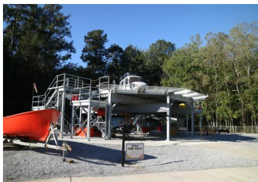
Pic.7 直升機滅火訓練場
