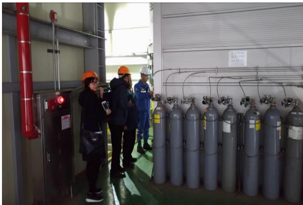
浦項集團仁川發電廠 TMS 站房外觀
