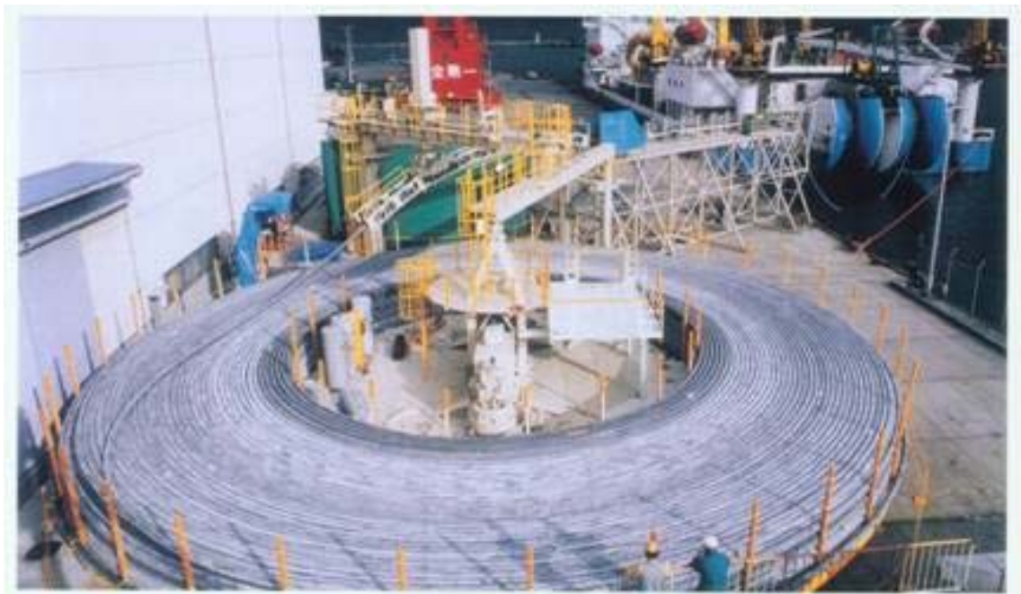
圖三、海纜鎧裝完成後直接輸送至運輸船
