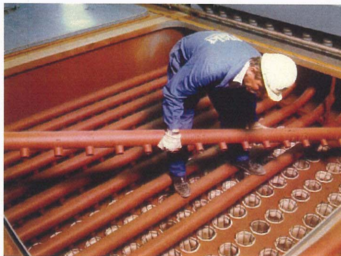
圖 33 噴嘴歧管拆除
