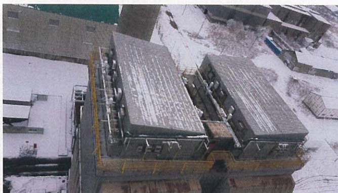
圖 48 ESP 改裝成 PRS 沿用靜電集塵器外殼
