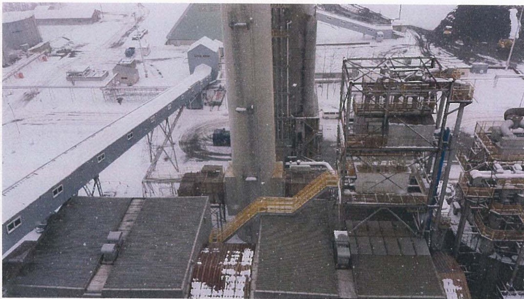
圖 56 鍋爐房頂端俯瞰整座電廠
