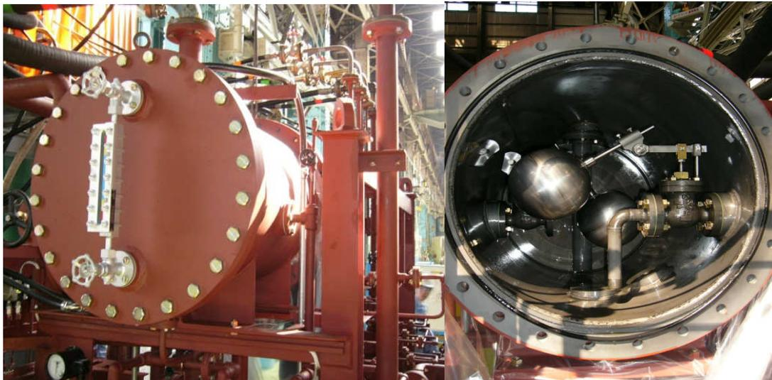
圖2-45 氫氣側卸油調整槽
