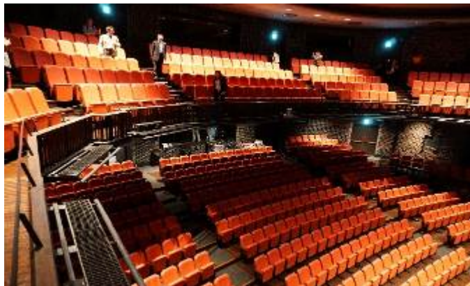
劇展演劇場參觀與解說：用密度較鬆散的磚頭，使之參差列以求吸音效果的设计，並在過程中與劇場總指導互動，了解劇場規劃中的精隨，並感受到他對自身專業的用心與人的敬業精神
