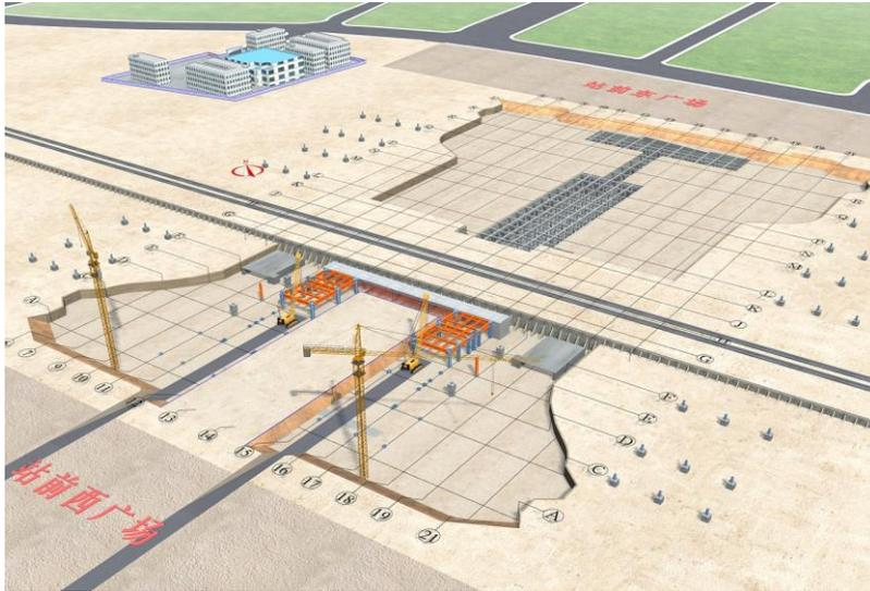
1. A-F轴地连墙施工完成，并进行开挖和基础施工，两侧钢构推进至D轴位置。
