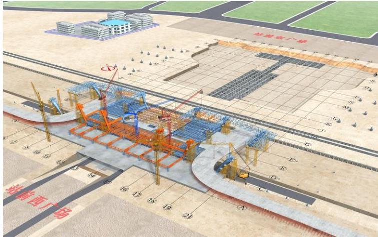
C-F轴高架层全面封闭，两侧屋盖主梁吊装基本完成。
