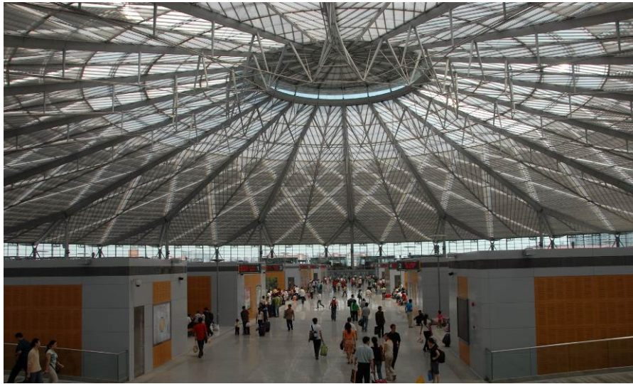
圖 110 直徑 200 公尺圓頂鋼桁架結構
