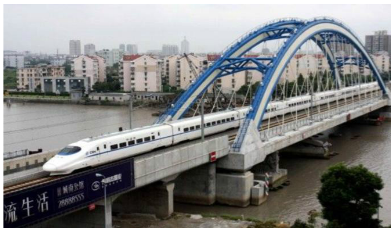
圖 122 大陸首次將提籃式鋼拱橋應用於高速鐵路橋梁
