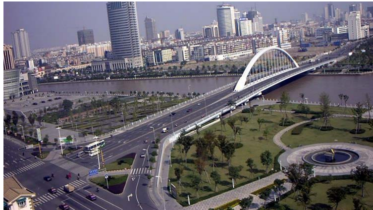
圖 118 橋梁西側連接寧波音樂文化廣場因而取名琴橋
