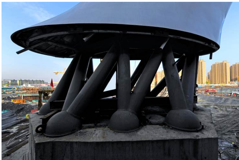
圖 7 杭州東站斜柱桁架構造基座
