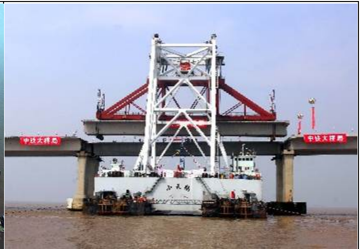
圖 141 跨度 70m 預力箱梁重 2200 噸，以 2500 噸小天鵝號海上運架船實施架設
