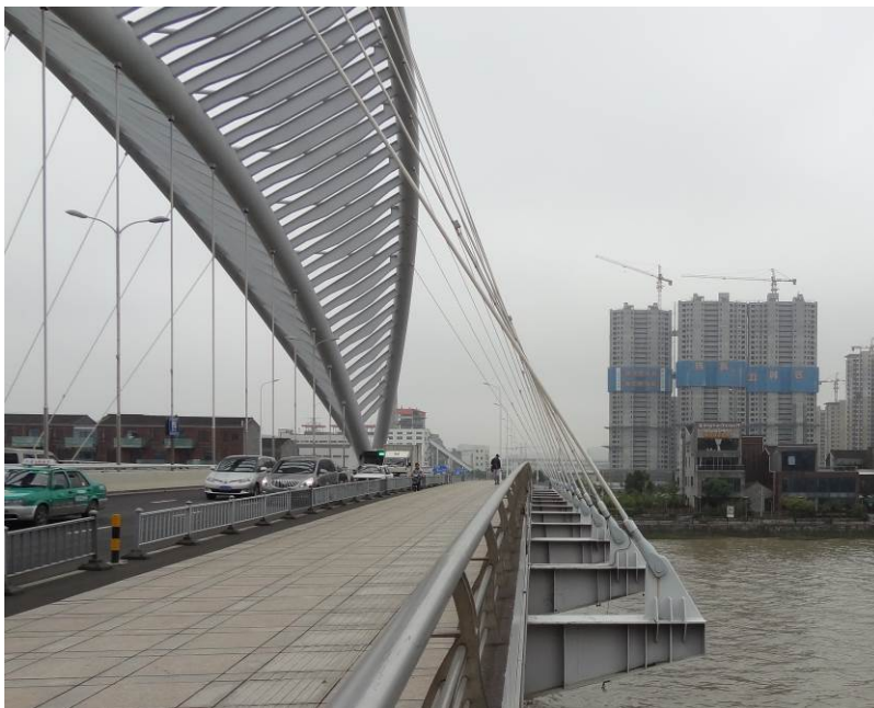
圖 134 長豐橋倒三角式鋼拱肋兩側以鋼纜錨碇於懸伸橫梁
