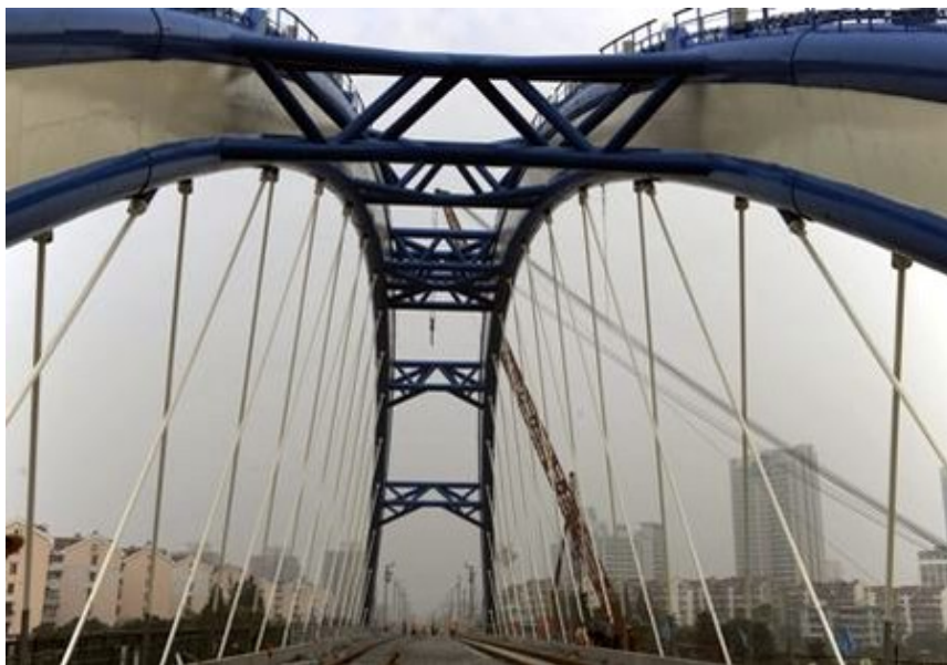
圖 125 奉化江大橋鋼拱肋及橫撐構件(摘至網路)
