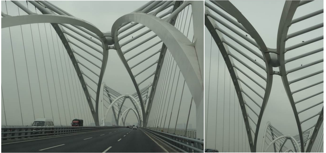
圖 115 九堡大橋橋橋上拍攝橋梁構造細節(一)
