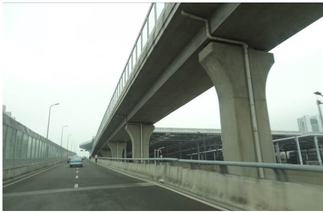
圖 30 以高架橋銜接地上 2 層鐵路出發層
