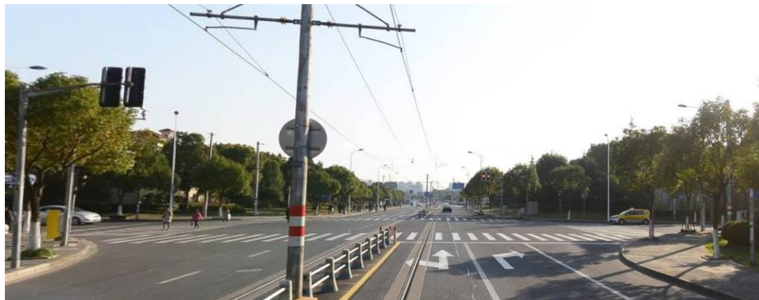
圖 56 路口處電車線、軌道、標誌佈設情形
