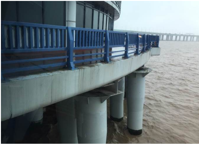
圖 143 觀景平台及樁基礎構造細節(一)
