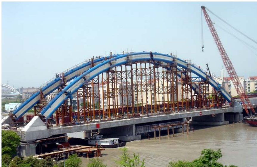
圖 124 奉化江大橋施工期間需維持奉化江航道船隻通行(摘至網路)
