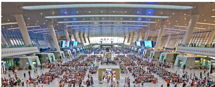
圖 11 杭州東站完工啟用內部候車大廳
