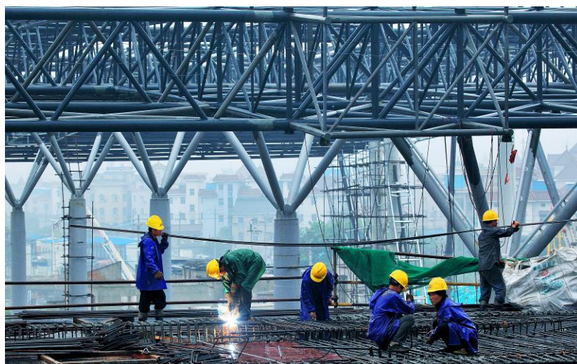
圖 8 杭州東站屋頂桁架細部構造
