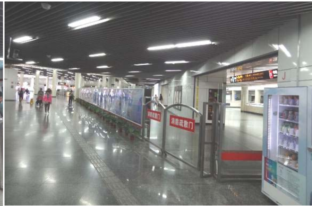
圖 83 人民廣場站付費區大型疏散閘門
