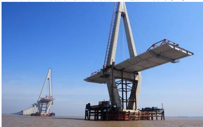
圖 149 北航道橋主跨 448m 採鋼床板箱型梁
