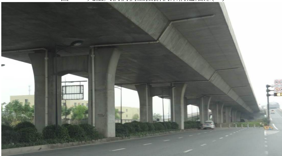
圖 117 九堡大橋橋兩端引橋
