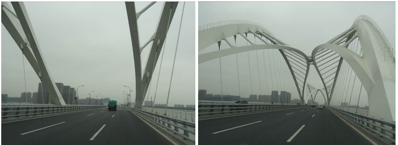
圖 116 九堡大橋橋橋上拍攝橋梁構造細節(二)
