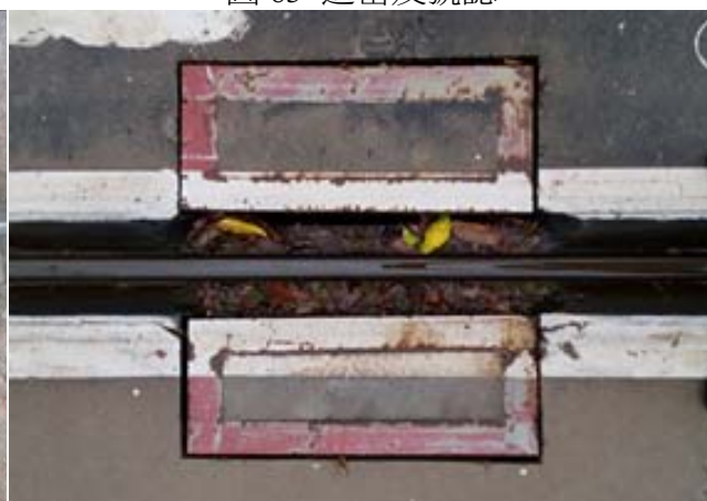
圖 64 注意軌道排水系統設計，降低感電風險
