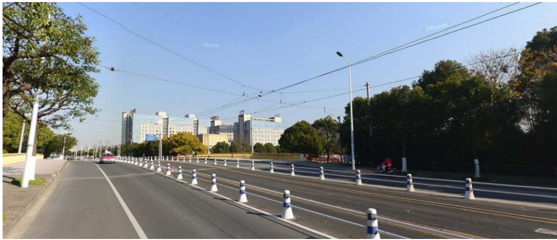
圖 55 跨越橋梁路段電車線、軌道佈設情形
