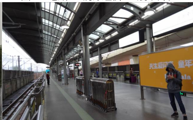
圖 79 地鐵 3 號線上海南站
