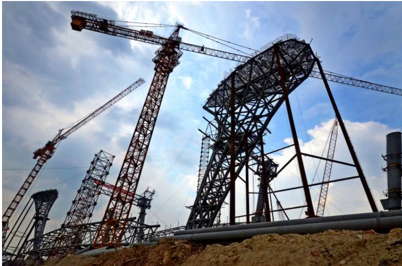
圖 6 杭州東站斜柱內部桁架構造及施工情形
