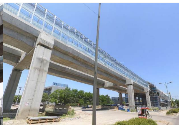
高架橋延續車站一致的造型元素
