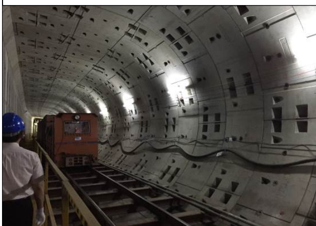
類矩形潛盾工法完成後隧道內部情形
