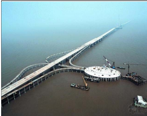
圖 140 杭州灣流向紊亂，潮流錯綜複雜，泥沙、海床運動多變，施工難度極高
