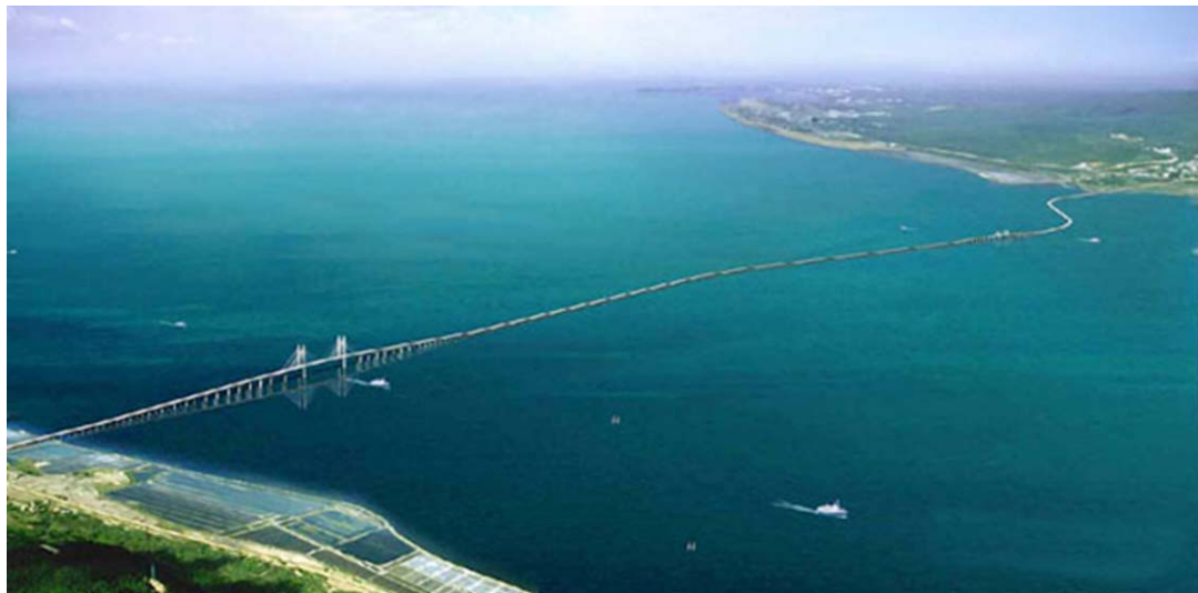
圖 137 杭州灣跨海大橋鳥瞰圖
