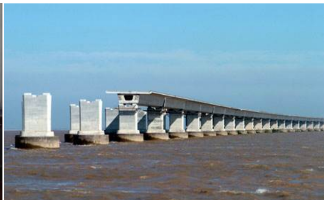
圖 148 跨徑 50、70m 預力箱型梁採預鑄吊裝
