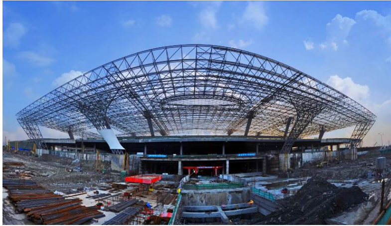
圖 5 杭州東站主體桁架構造完成情形
