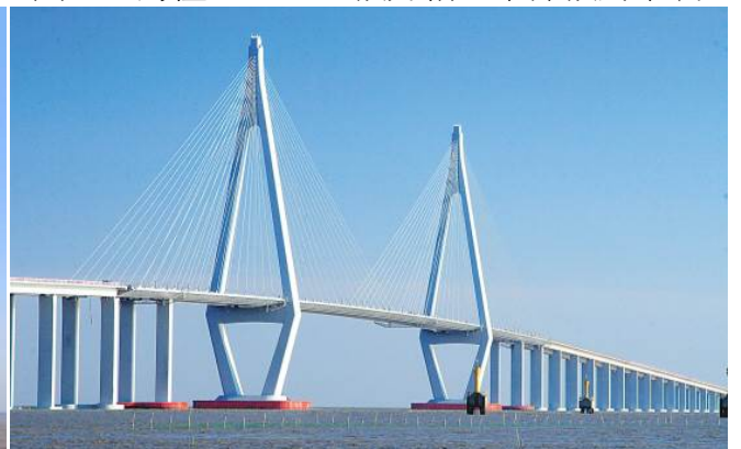
圖 150 北航道橋完工照片
