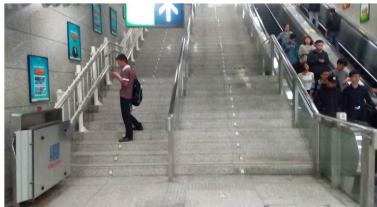
圖 44 未設置電梯，於樓梯設置行動不便設施
