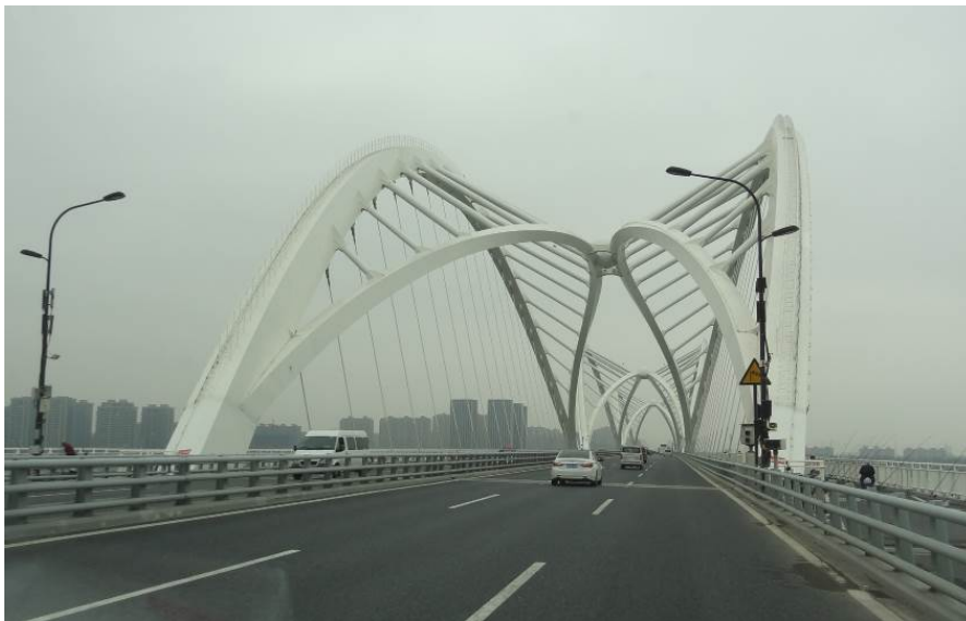
圖 114 九堡大橋橋橋上拍攝橋梁全景
