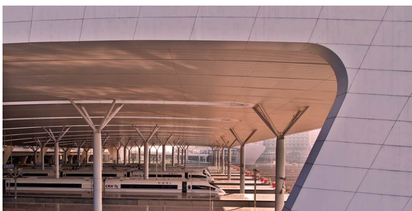
圖 9 杭州東站屋頂裝修完成情形
