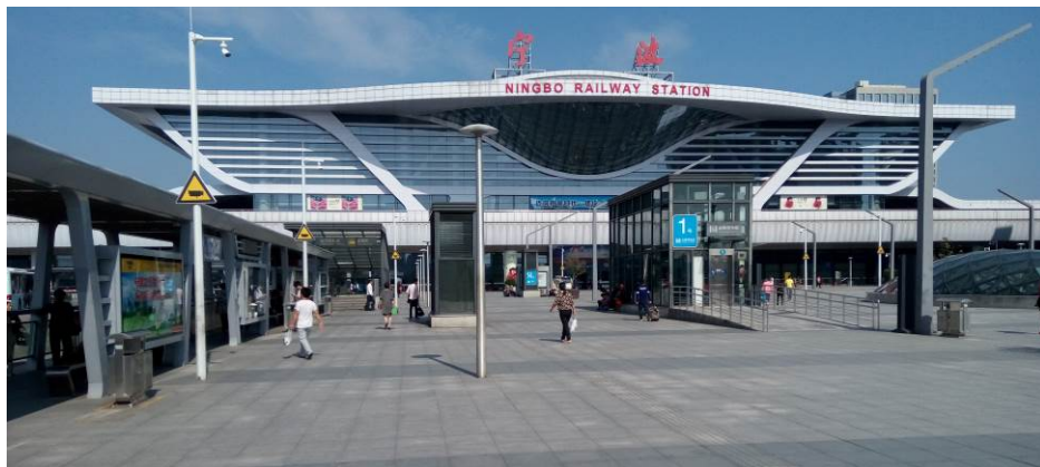
圖 32 站車站地面層出入口
