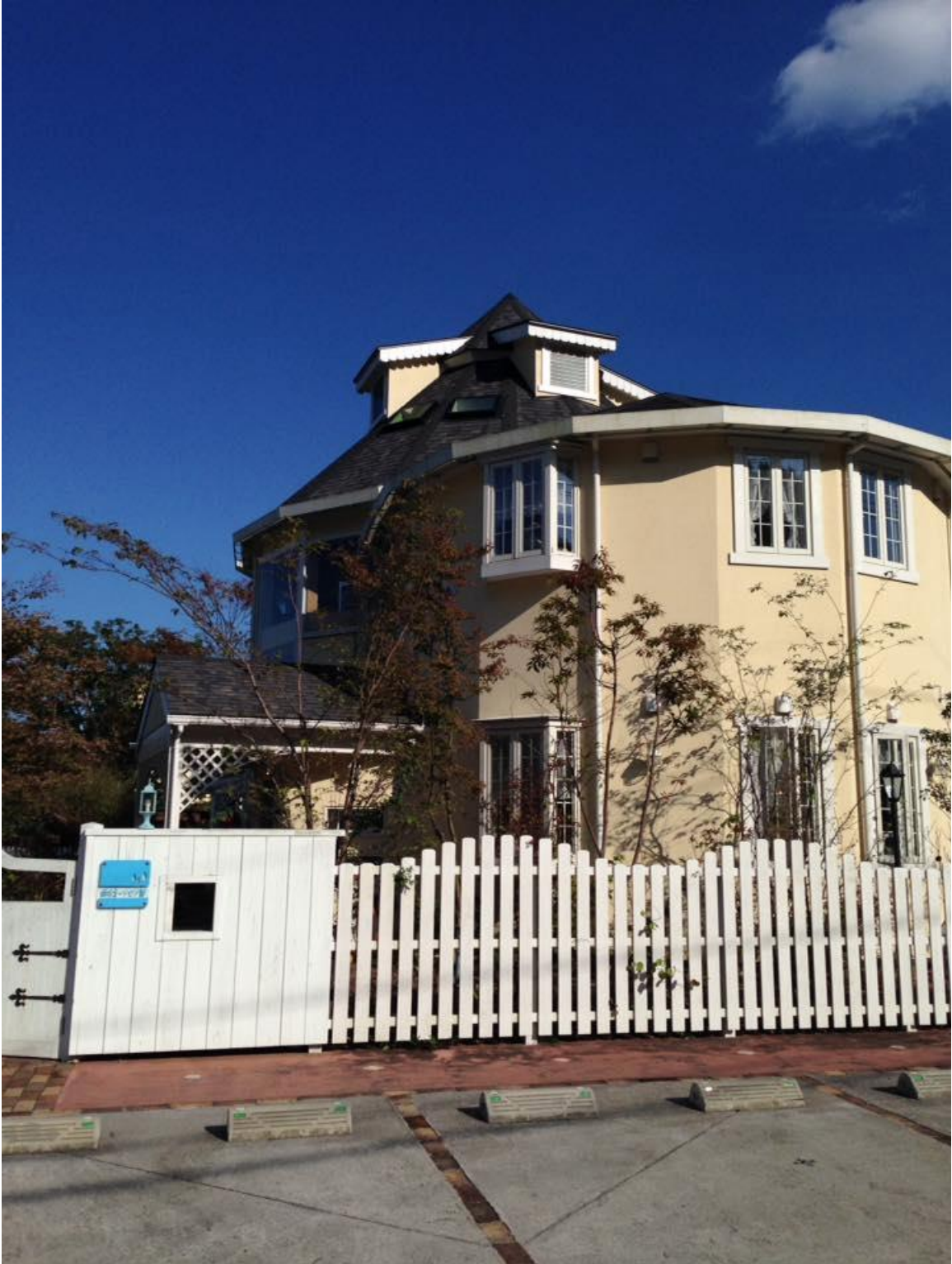
照片33 PreCut工法製成結構外觀
