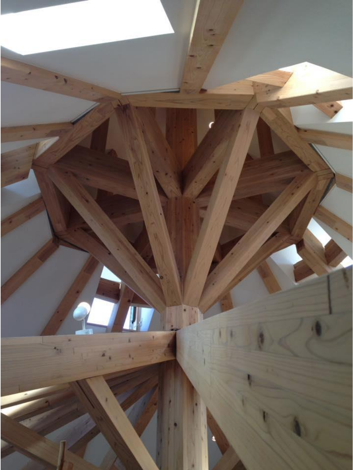
照片32 PreCut工法製成之圓錐形屋頂結構
