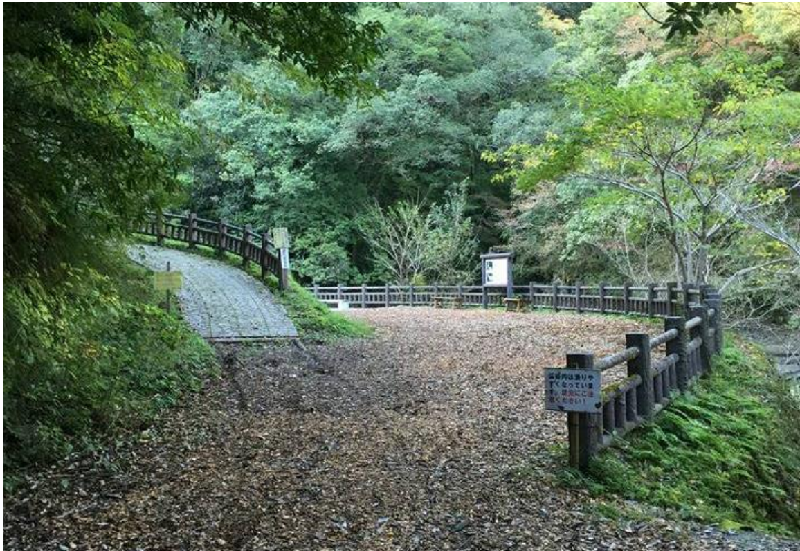
照片 35 由約30 cm厚碎木屑鋪成之步道
