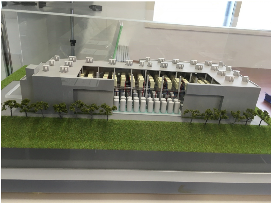
照片 21、南早來變電所儲能示範廠模型
