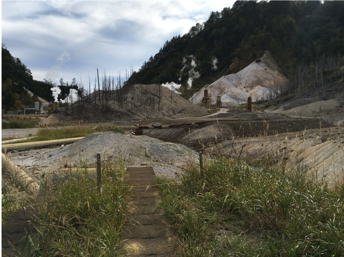
照片 15、鬼首地熱發電所噴汽事故現場
