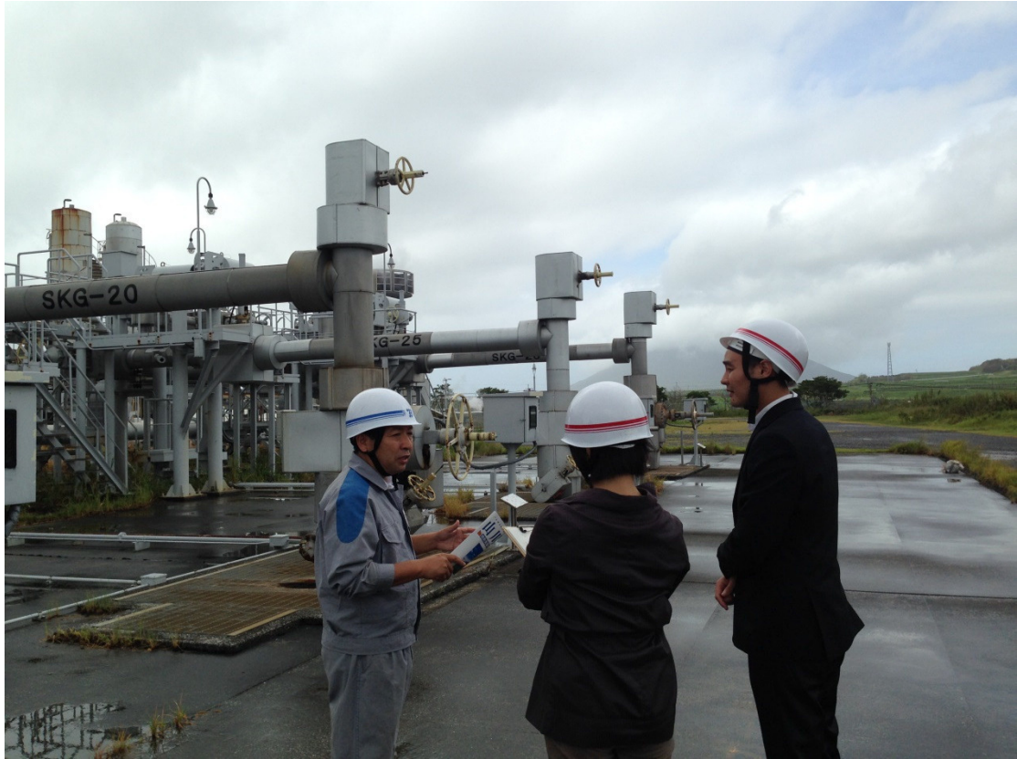
照片 5、山川地熱發電所生產井基地
