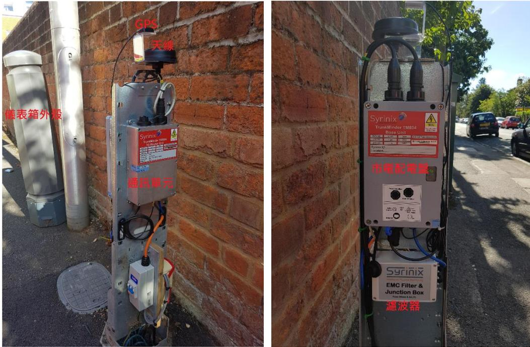
管線漏水監測設備儀表箱及內部配置
