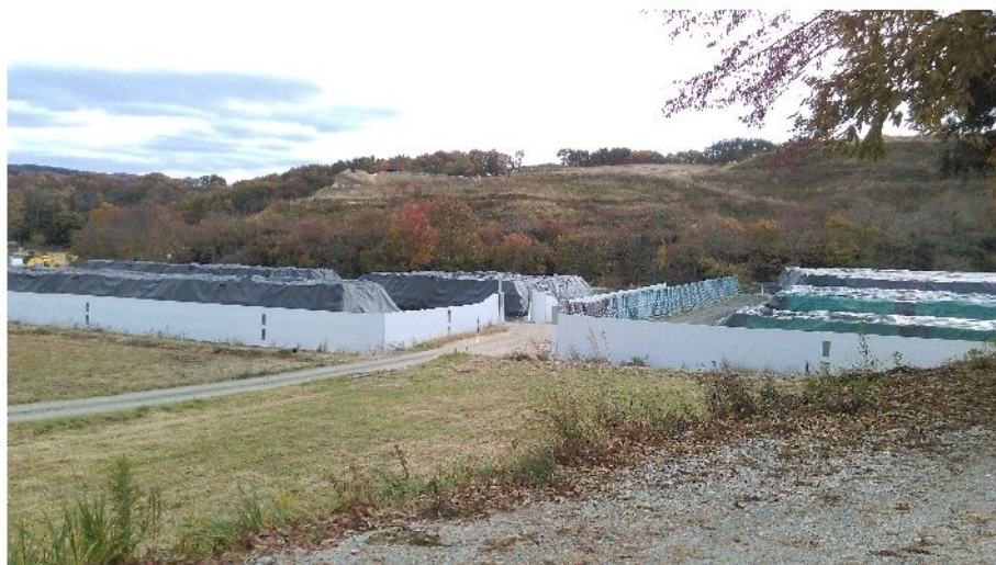
圖 5 川俣町山木屋地區除污廢棄物堆置場
