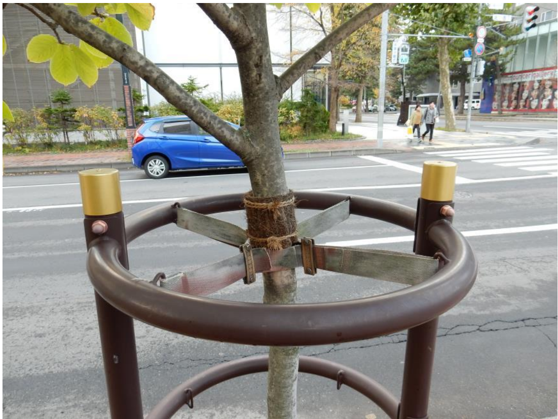
圖14、札幌市行道樹支架設置情形，提供樹木直立所需的支撐。
