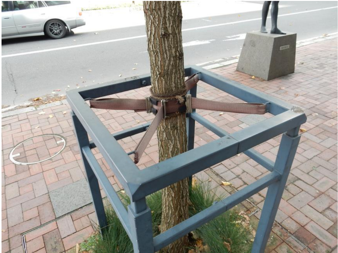
圖13、札幌市行道樹支架設置情形，可防範樹木受強風吹倒。
