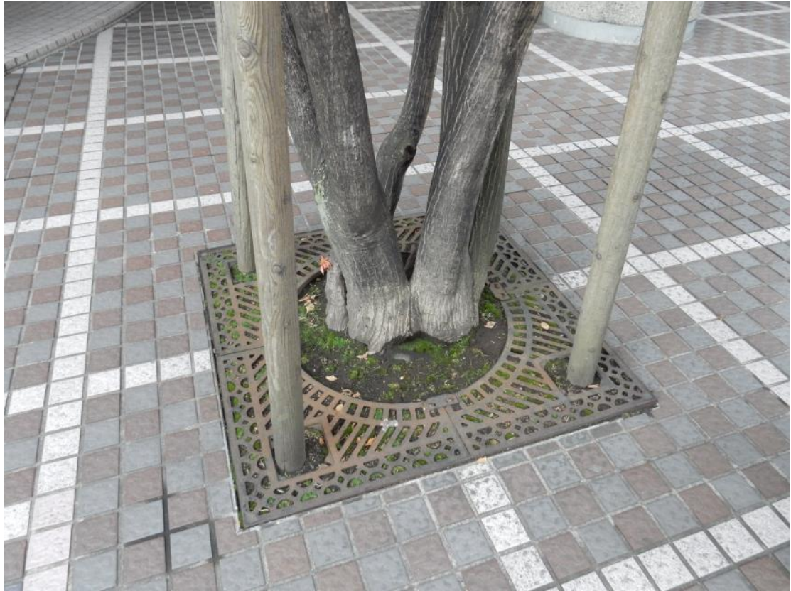
圖15、札幌市行道樹根基部設置保護蓋，避免樹木根基部受行人踐踏。
