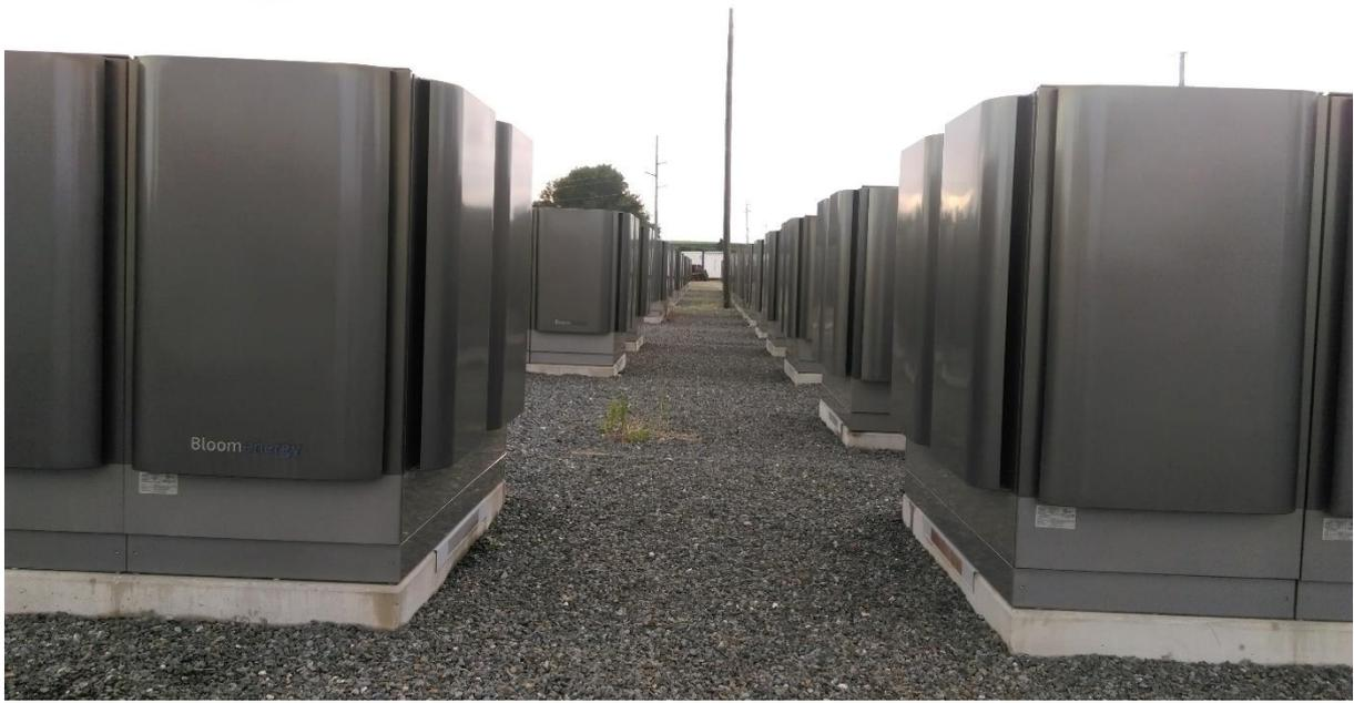
圖 13. 美商 Delmarva Power 公司 Red Lion 27 MW SOFC 發電系統實景 3
