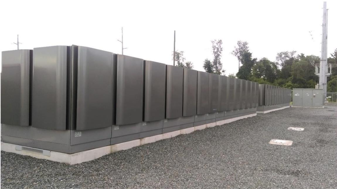
圖 12. 美商 Delmarva Power 公司 Red Lion 27 MW SOFC 發電系統實景 2
