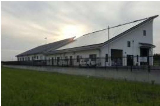
E. 屋頂太陽能面板
