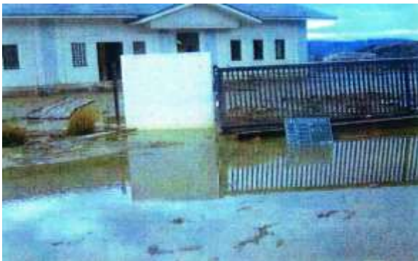
C. 著手前處理設施全景
