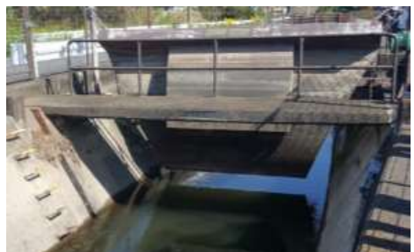
H.彌勒水位調節堰
