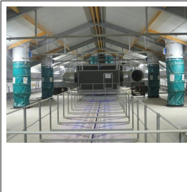
圖三十七、Vencomatic X-Treck on farm hatching 立體式白肉雞飼養場樓頂溫控設備及中控室
