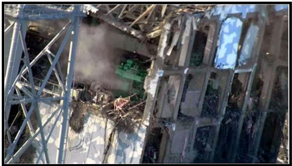
圖 14 氫氣爆炸後一縷白色輕煙從 4 號機組上升 (摘自東京電力公司 2011.03.16)
