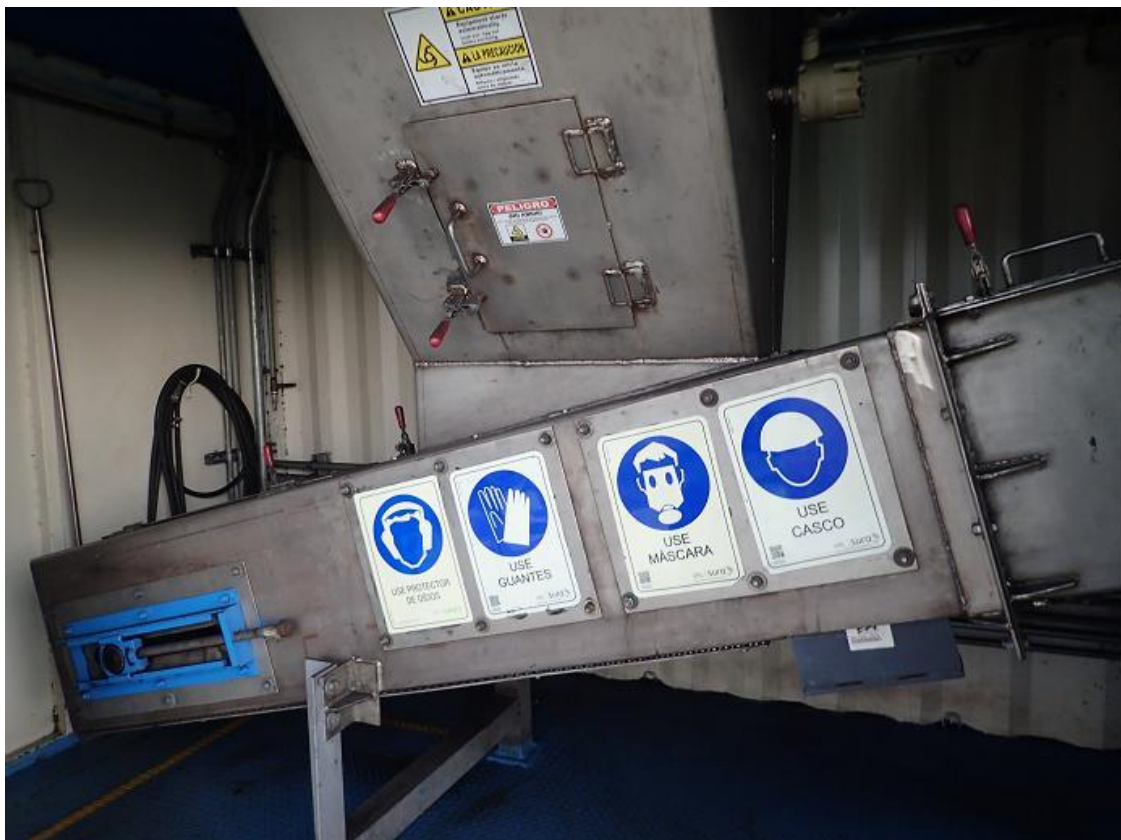
圖152 Puerto Nuevo裝煤碼頭取樣設備
