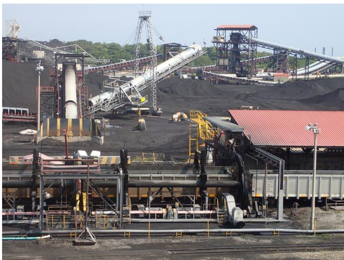
圖93 Puerto Drummond產品煤儲煤場與火車卸煤站(翻轉式)
