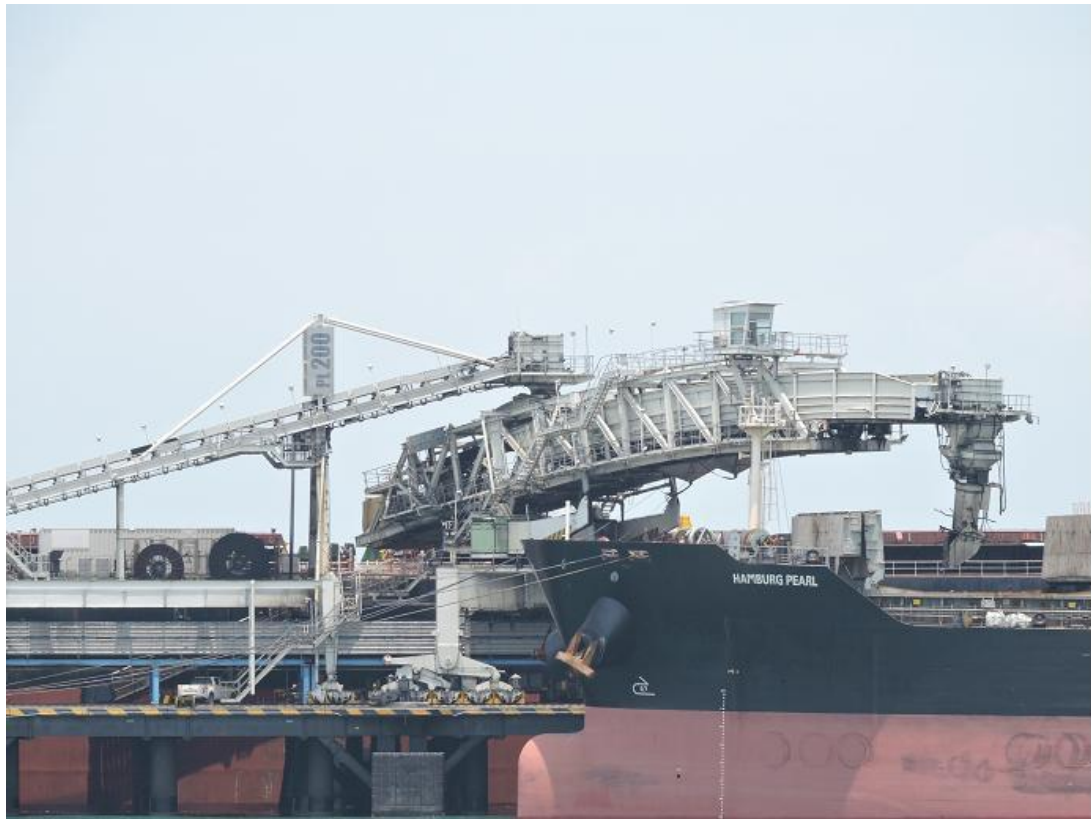
圖161 Puerto Nuevo裝煤碼頭Shiploader
