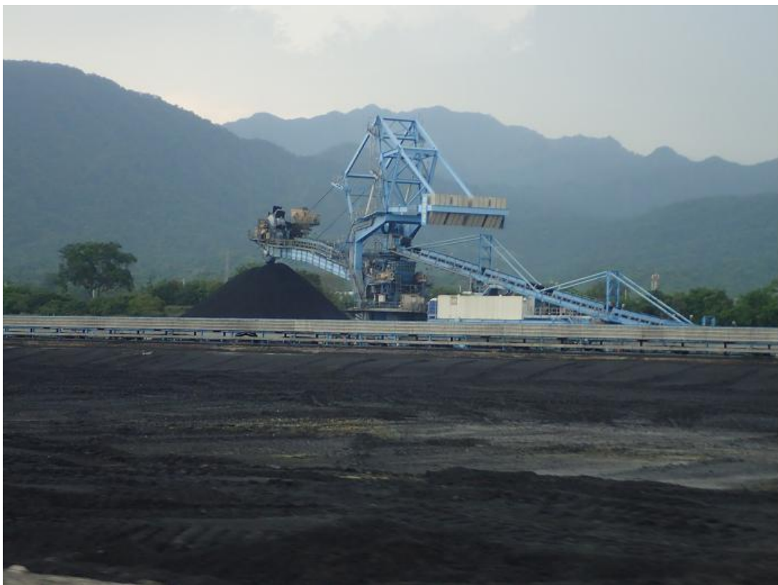
圖147 Puerto Nuevo堆煤機作業
