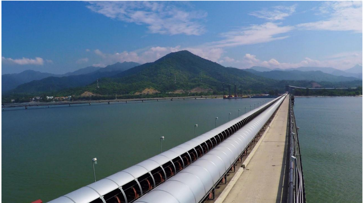
圖104 Puerto Drummond棧橋與封閉式輸送皮帶
