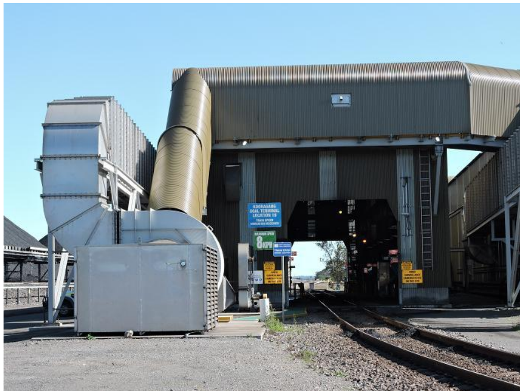
圖36 PWCS火車卸煤站
