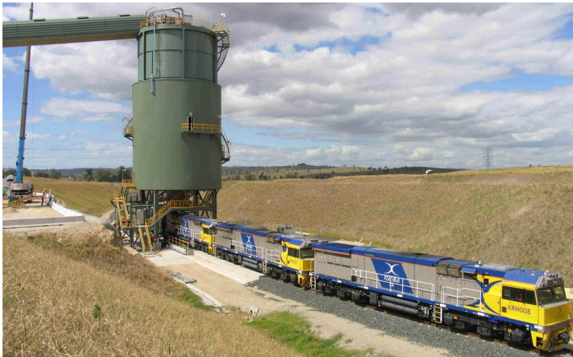
圖28 Mangoola礦區火車裝運站(Train Load Out)
