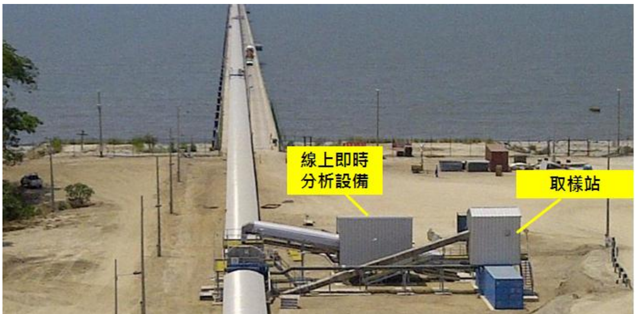
圖154 Puerto Nuevo裝船時取樣站及線上即時分析設備
