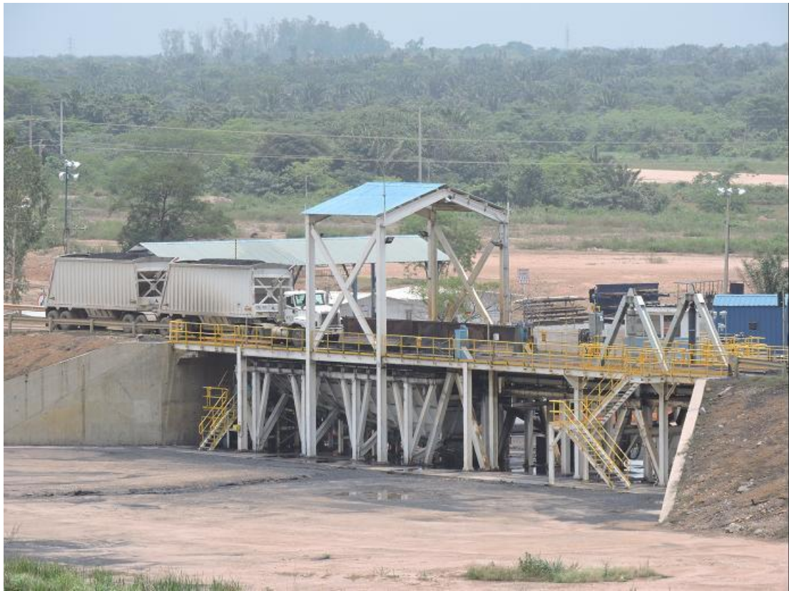
圖135 Prodeco礦區卡車卸煤站
