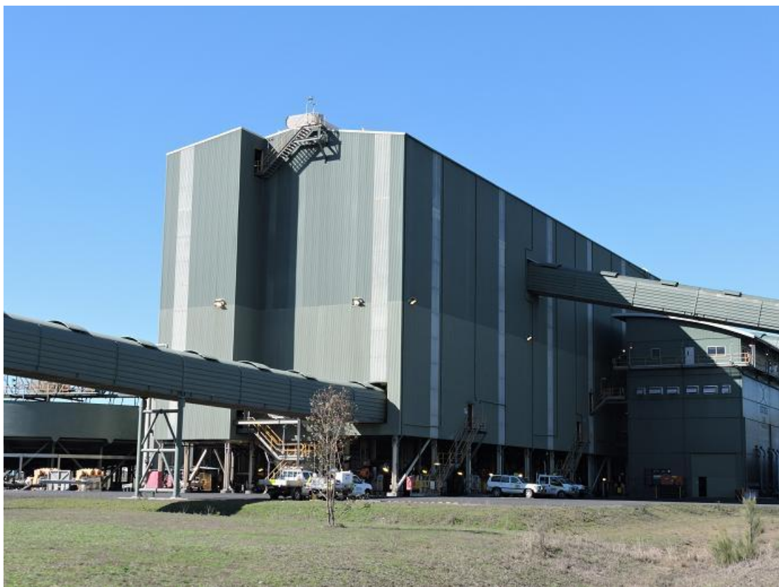
圖17 Mangoola礦區洗煤廠(CHPP)
