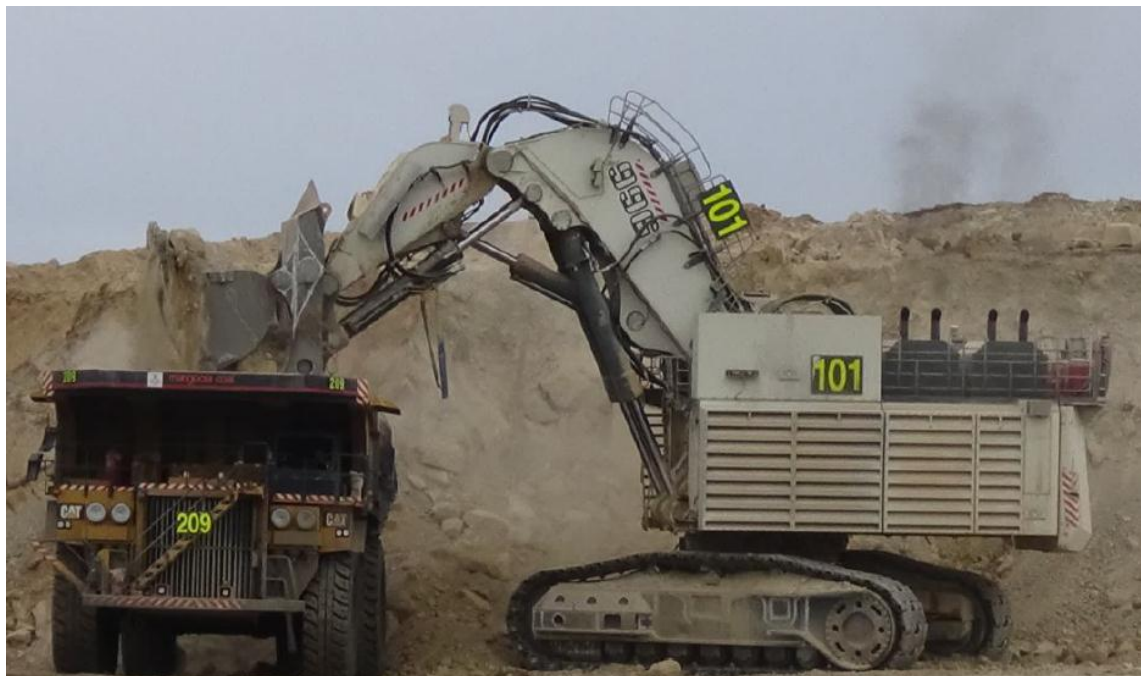
圖10 礦區設備(Face shovel (Liebherr))
