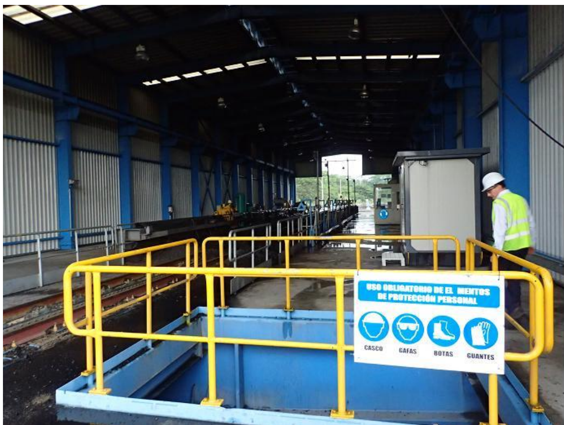
圖144 Puerto Nuevo裝煤碼頭火車卸煤站
