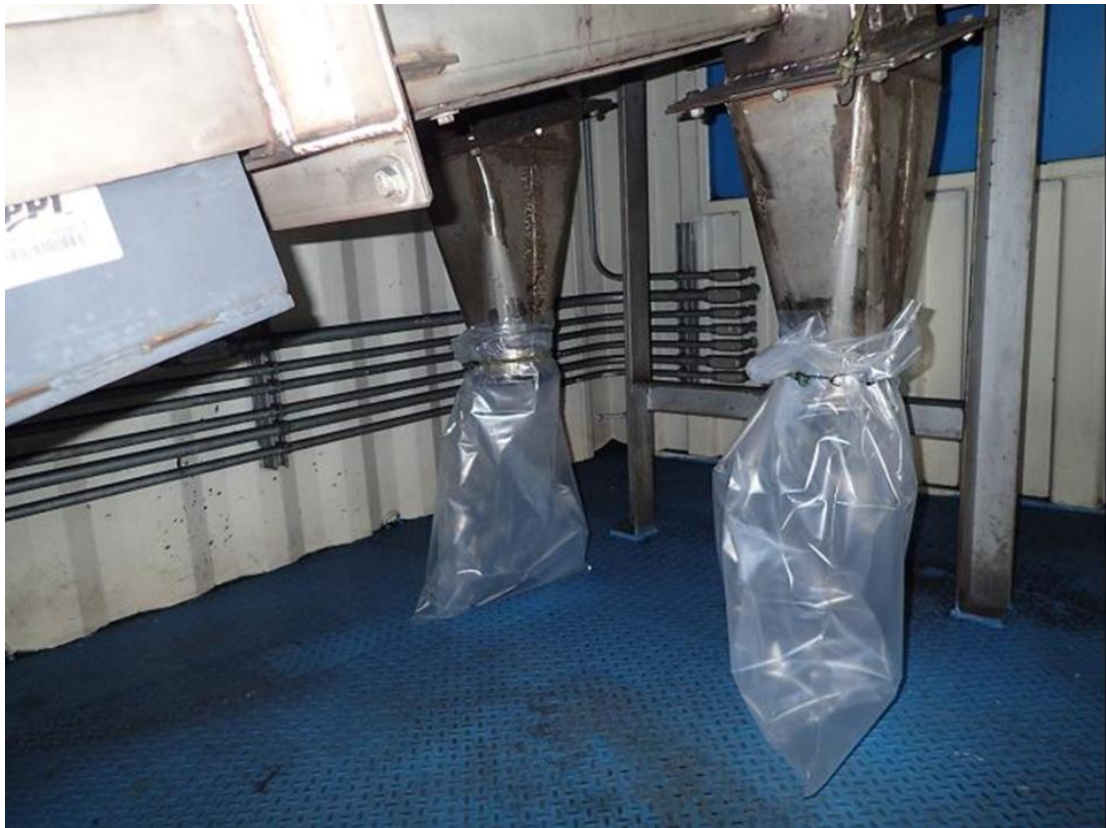
圖153 Puerto Nuevo裝煤碼頭取樣
