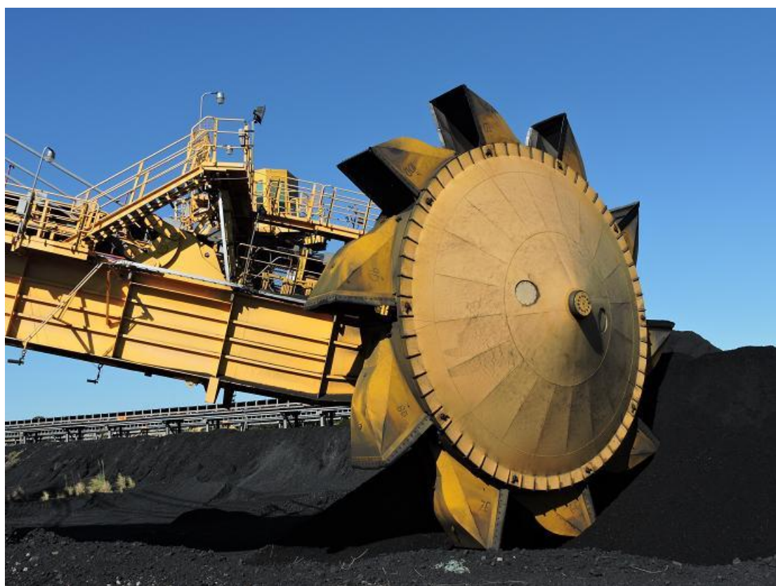
圖42 PWCS斗輪式堆/取煤機取煤作業
