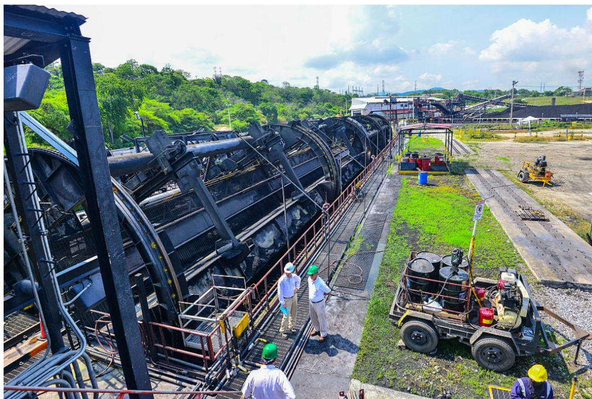
圖95 Puerto Drummond火車卸煤設備維修(四列車廂)(翻轉式)
