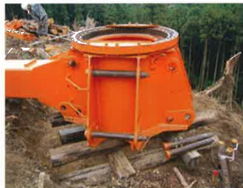
圖 20 中心單元基座設置
