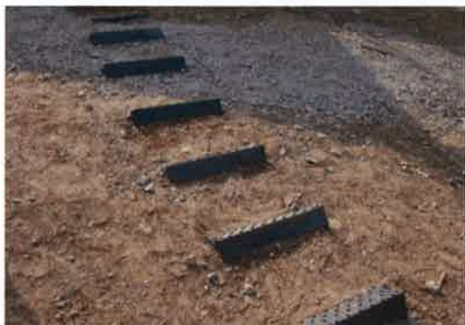
圖 59 橡膠階梯通道
