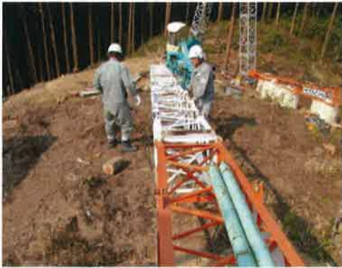
圖 31 吊臂單元安裝
