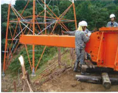
圖 21 水平腳架裝設
