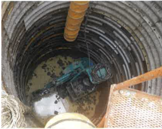
圖 52 深層採開口式波浪鋼板照
