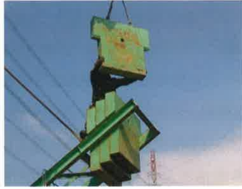
圖 30 平衡塊吊放安裝
