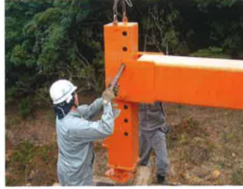
圖 22 垂直支撐腳架設置
