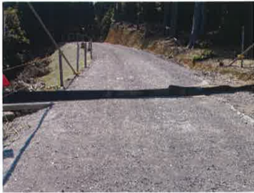
圖 11 搬運道路面截水橡膠片
