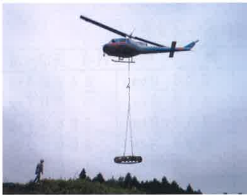
圖 15 直昇機吊運挖土機履帶
