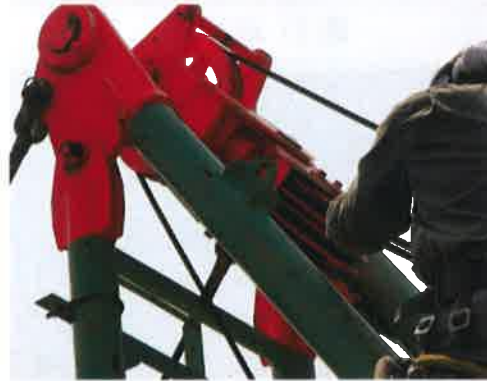
圖 34 鋼索轉盤安裝
