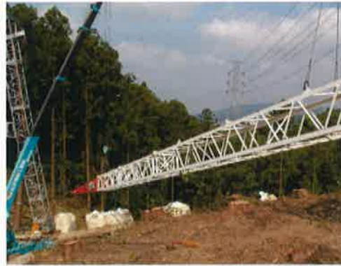
圖 32 吊臂吊放
