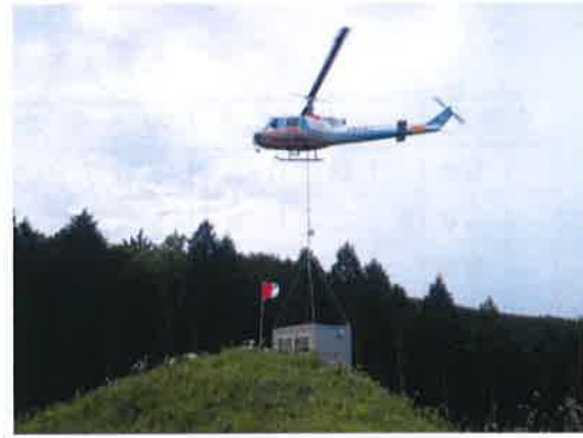
圖 16 直昇機吊運貨櫃屋
