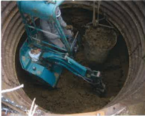
圖 46 小型挖土機(1)
