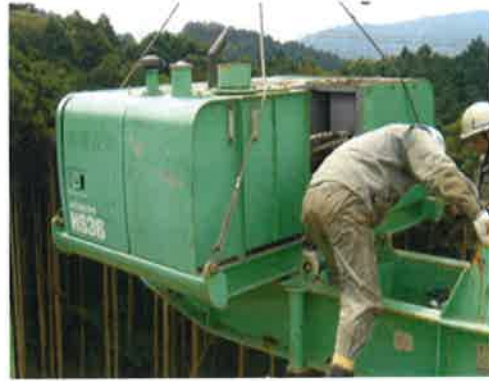
圖 24 動力裝置安裝
