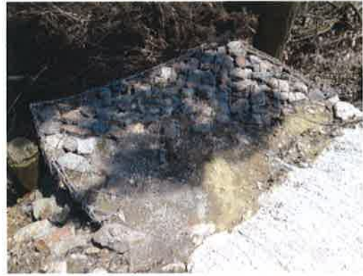
圖 12 搬運道旁石籠消能池
