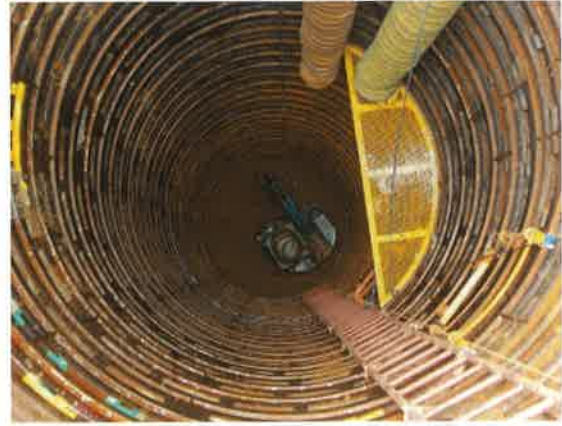
圖 53 全面採開口式波浪鋼板照
