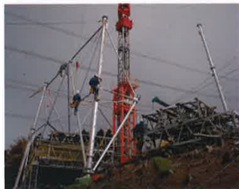
圖 38 塔吊裝建鐵塔構件
