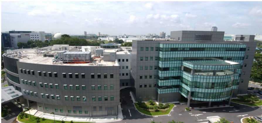
圖 18 新加坡 WaterHub 外觀
