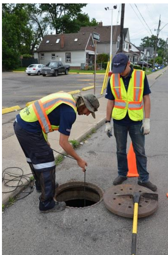
圖 33 加拿大 Echologics 之 EchoWave® 檢測示意
