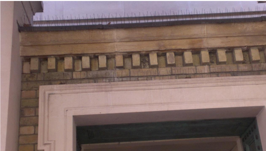
門框上及屋沿防鳥停留之小突出物，防止鳥類停留造成污染
