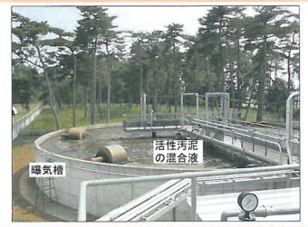
大型・円形の曝気槽にを用い、1日に1回投入・放流を行う回分式活性汚泥法。
