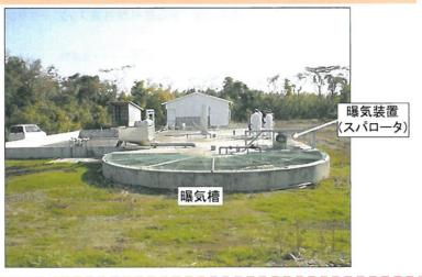
長円・溝型(ディッチ)の曝気槽を用い、1日に1回投入・放流を行う回分式活性汚泥法。
