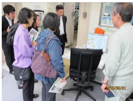
圖 17 污泥脫水機房中控室
