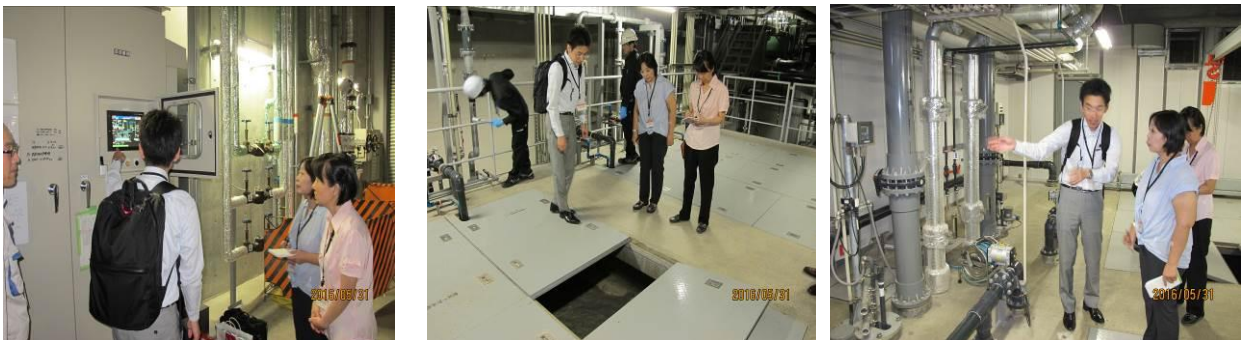
圖 7 MBR 操作控制、槽體內部及外部管線說明
