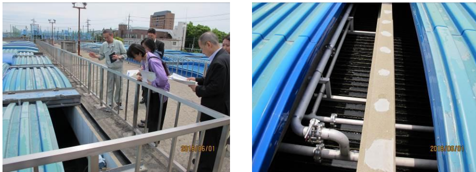
圖 16 橫流式沉澱池及傾斜板單元
