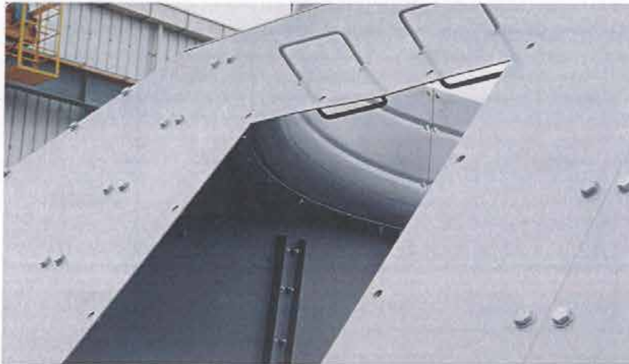
Plenum 向內觀看 Fan ring 組裝狀況
