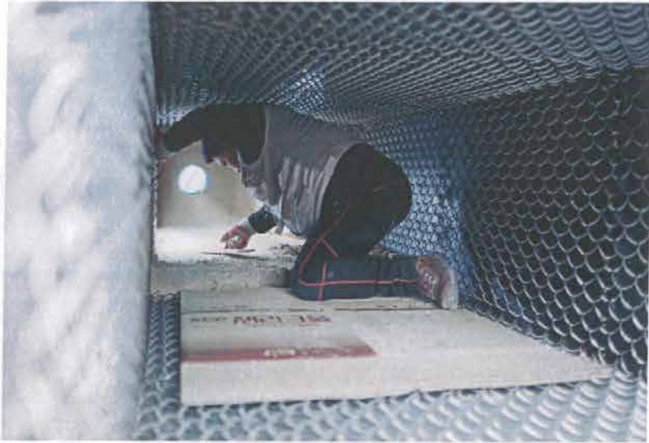
耐火泥塗覆作業
