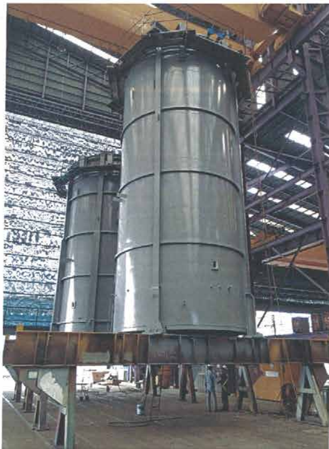
本案加熱爐 F-3001 及 F-3101 輻射區段噴砂油漆中
