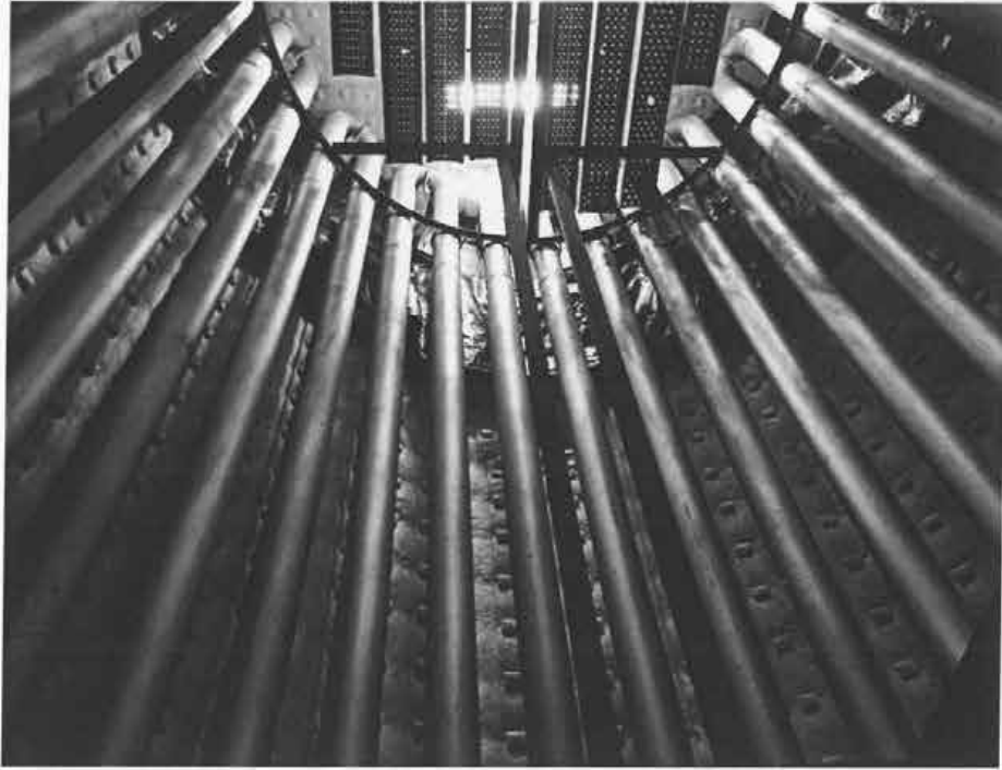
本案加熱爐輻射區內爐管
