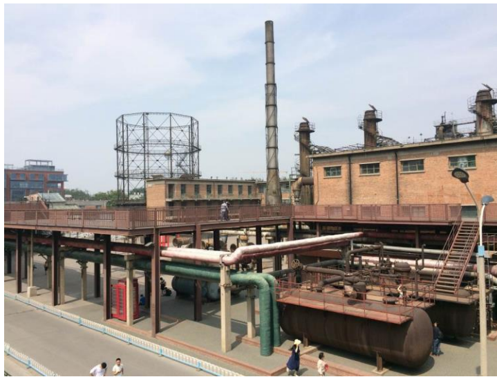
798 藝術區內大型機械設備遺址
