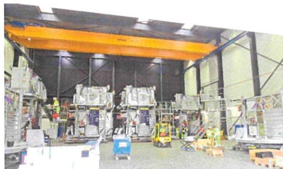
圖 29 風機內機電設備預組立廠房內部
