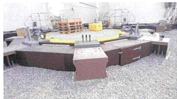
圖 27 碼頭旁風機塔架組立之基礎
