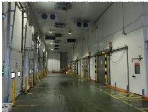
左側進出貨碼頭·右側為冷倉庫門
