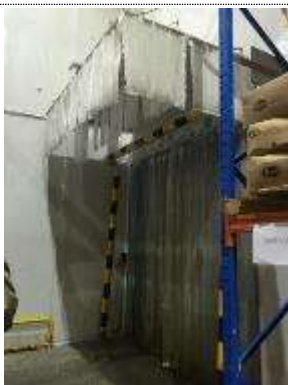
冷凍區出入口
