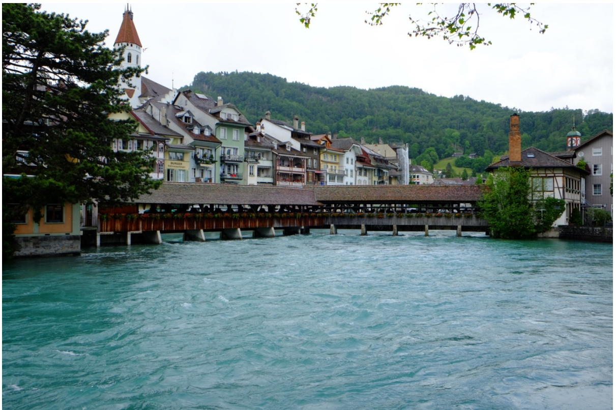
圖 36 圖恩市內 19 世紀操作至今水門
