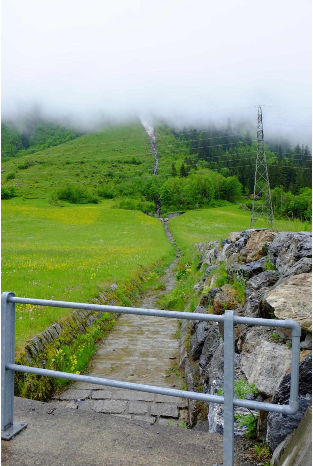
圖 21 野溪兩岸坑溝整治，坑溝源頭為冰河，融化過快易導致山洪暴發
