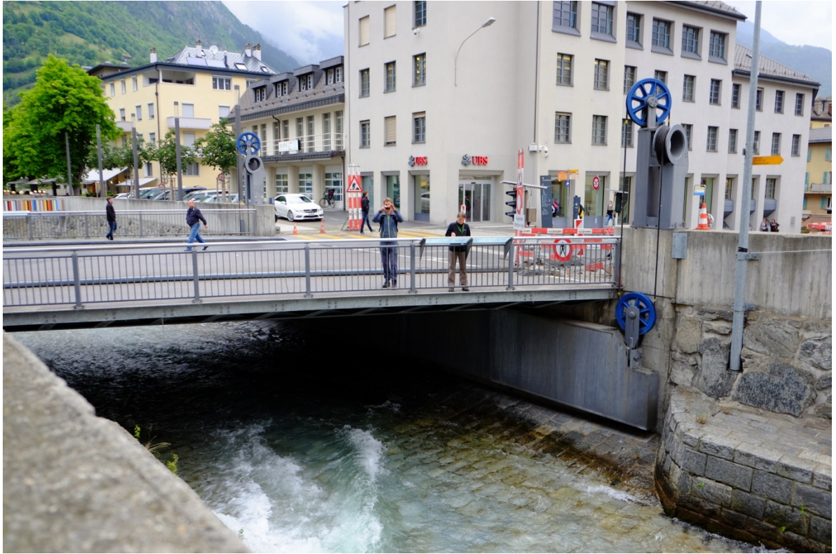
圖 23 布利格橋現已改建為自動升降(利用水壓力)
