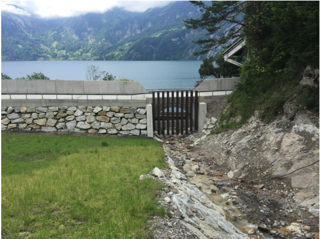
圖 16 土石流沉砂滯洪池
