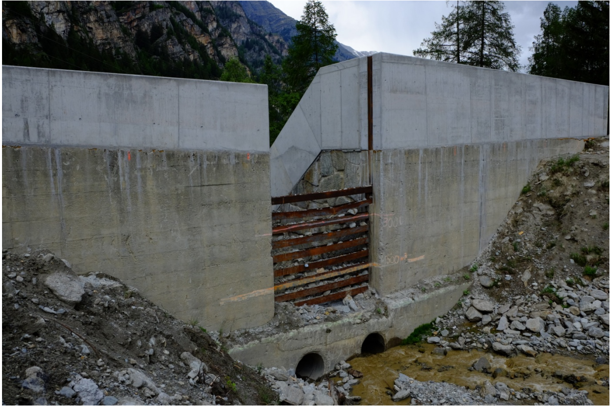
圖 31 格柵壩滯洪沉砂池以消能
