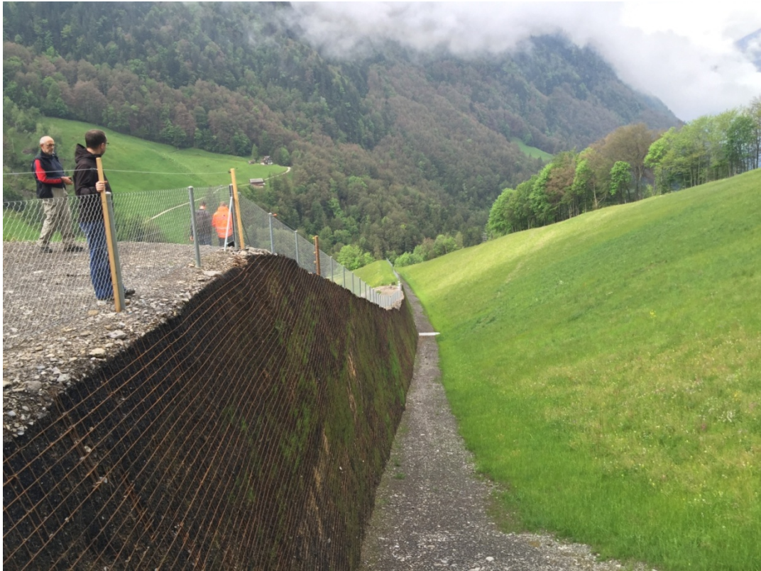
圖 13 土石流保護壩，壩體正面後續噴植以利植生
