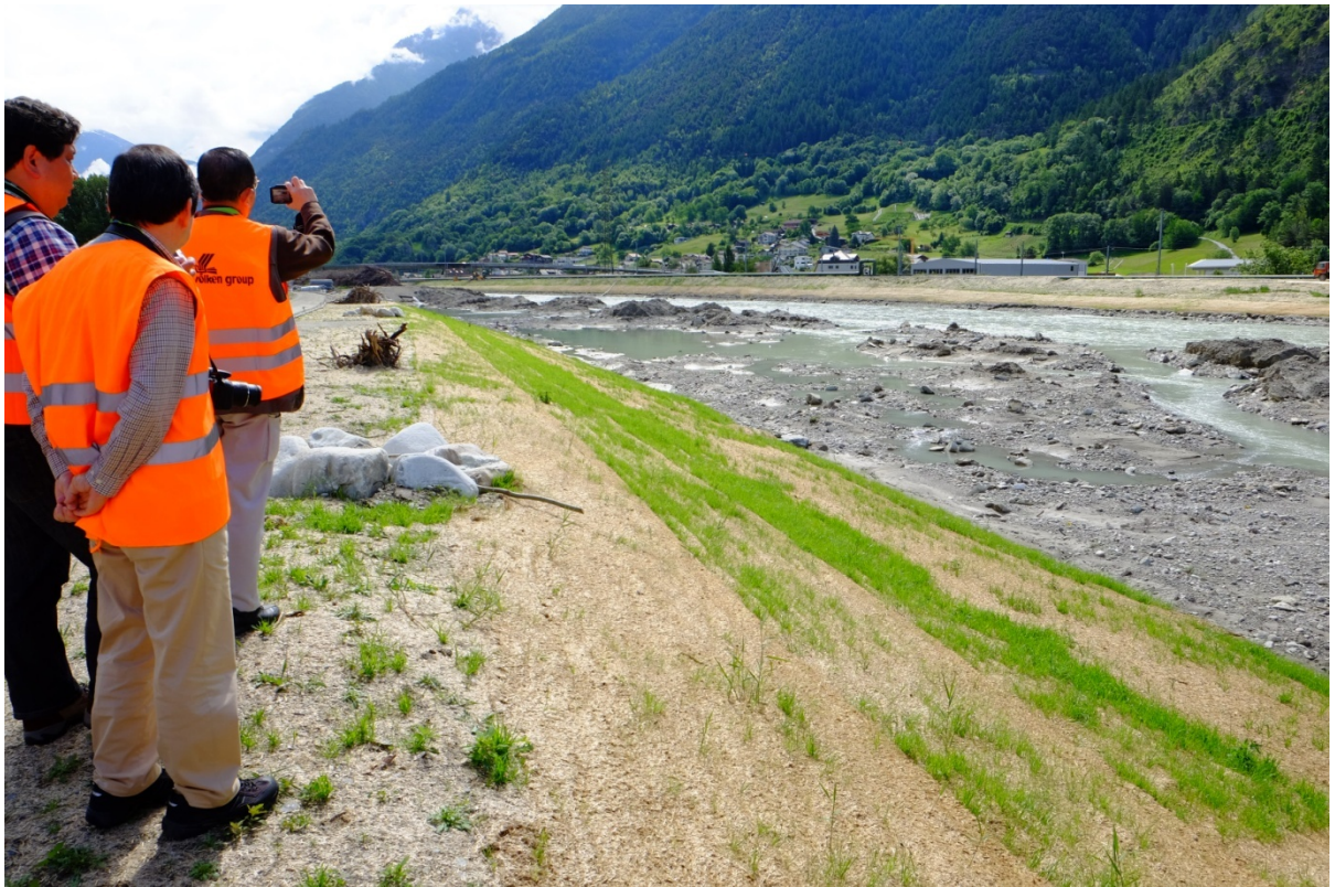
圖 26 現場勘查隆河堤防工程
