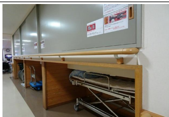
走道扶手壁有規劃病床等物品存放空間
