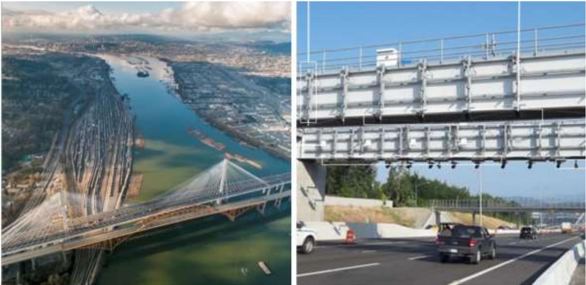
圖 3. Golden Ear 橋梁(各出入口)與 Port Mann 橋梁及其電子收費系統路側設備
