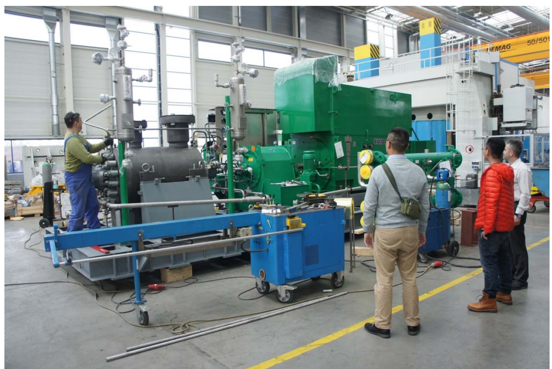
4/12 狀態: P-2001B 尚在組裝區準備配管工作，照片中工人正在安裝 Seal Pot 到機械軸封間的不銹鋼 tube。
