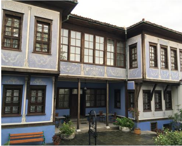
Hindliyan House, Stepan Hindliyan 是位富甲一方的商人，房屋建於 1830 年代，目前有很多文化活動在內舉辦
