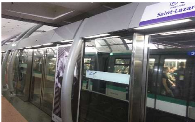
圖 4.50 巴黎地鐵 14 號線 Saint lazare 車站月臺門
