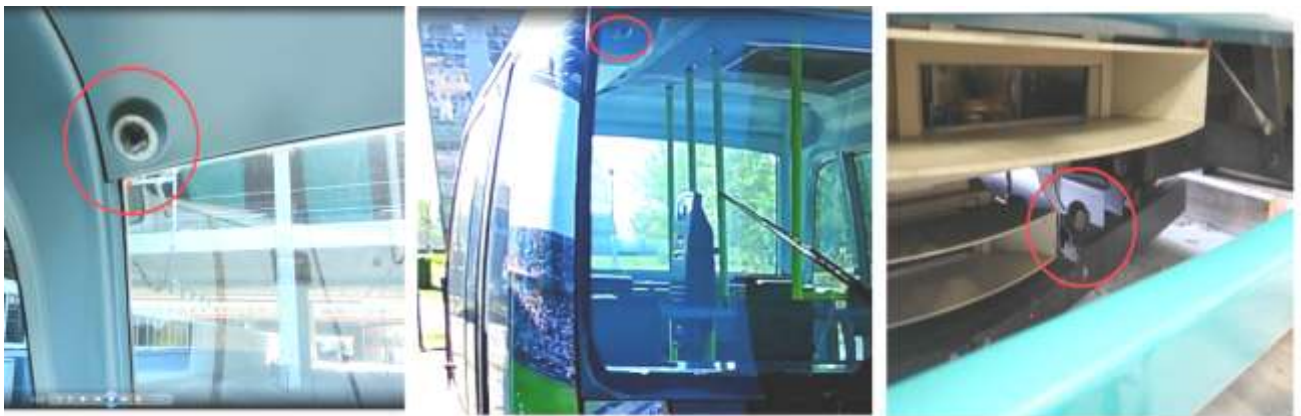
圖 4.18 GRT 車廂 CCTV 攝影機
