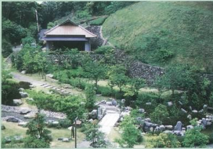
▲万葉公園休憩所排水処理施設
