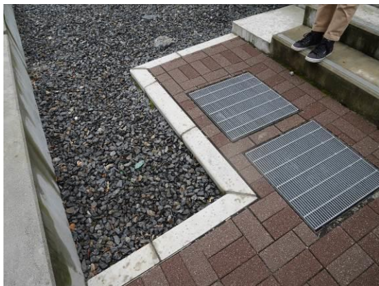
設有水路將多餘雨水引入中央池
