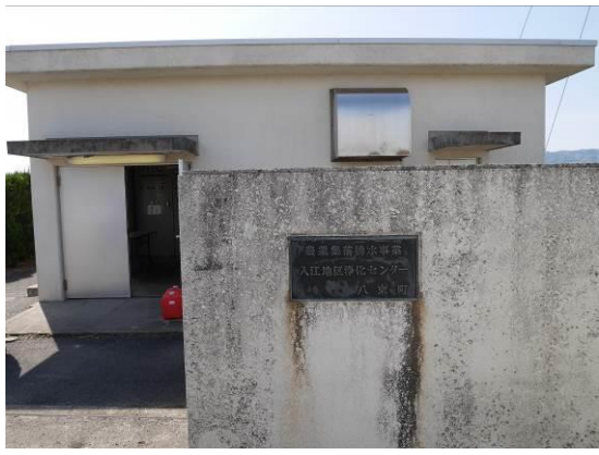
入江地區農村集落污水處理設施建築物外觀
