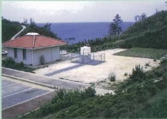
▲石見海浜公園Fゾーン汚水処理施設
