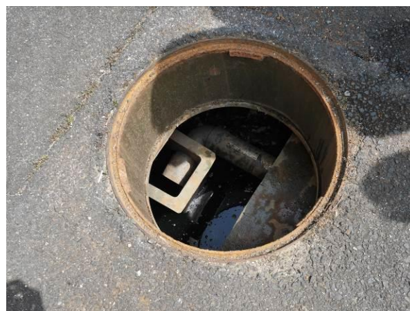
沈澱分離池内部
