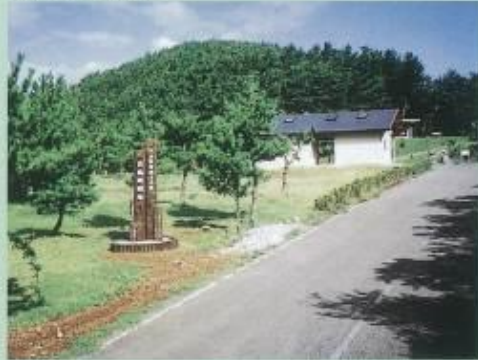
▲隠岐白島麓展望台汚水処理施設
