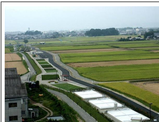
伯母川城市型污水處理設施空照圖(摘自草
