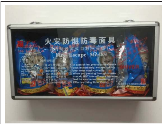
閱覽區牆面設置火災防煙防毒面具
