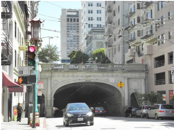
斯托克頓街隧道北口
