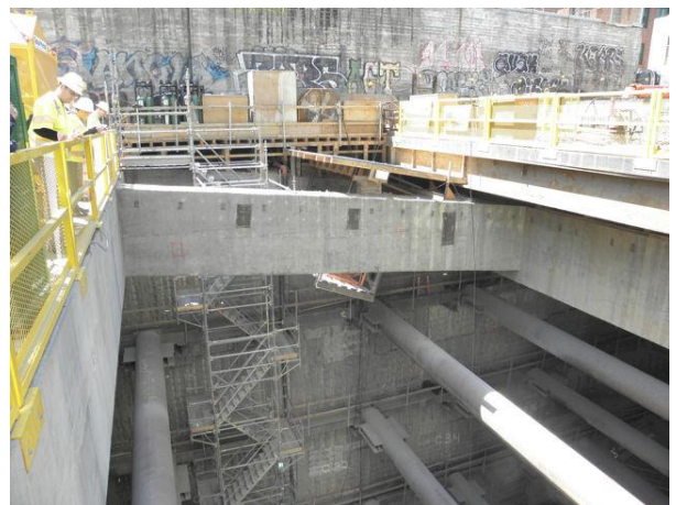
車站 1 樓之永久結構先行施作，以 增加支撐勁度
