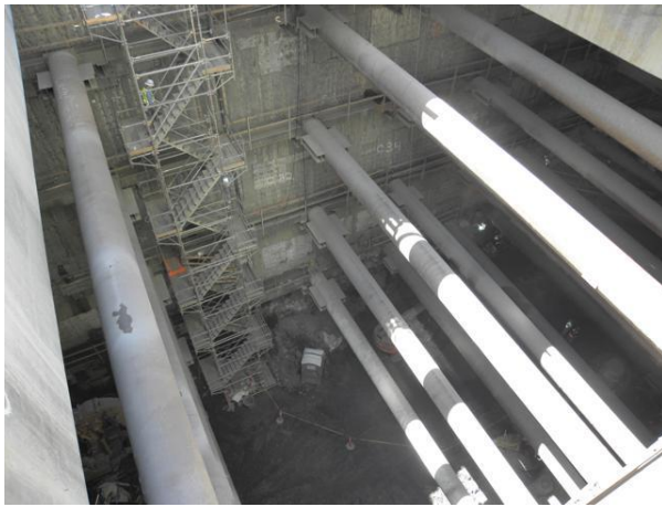
採鋼管水平支撐，共 4 階
