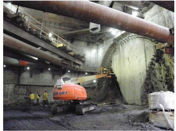
與隧道之連通道先撐鋼管打設作業
