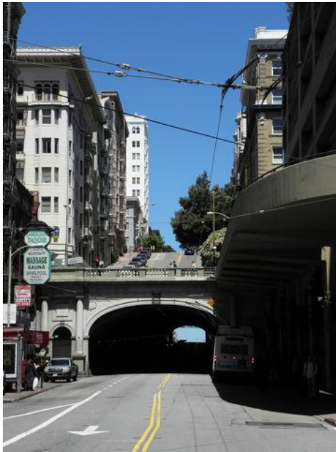
斯托克頓街隧道南口
