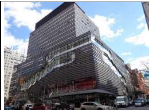
PARSONS 學院風格特殊的建築。
