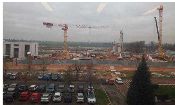
圖五：進行中的歐洲矽谷（Plateau de Saclay）計畫之建築工程
