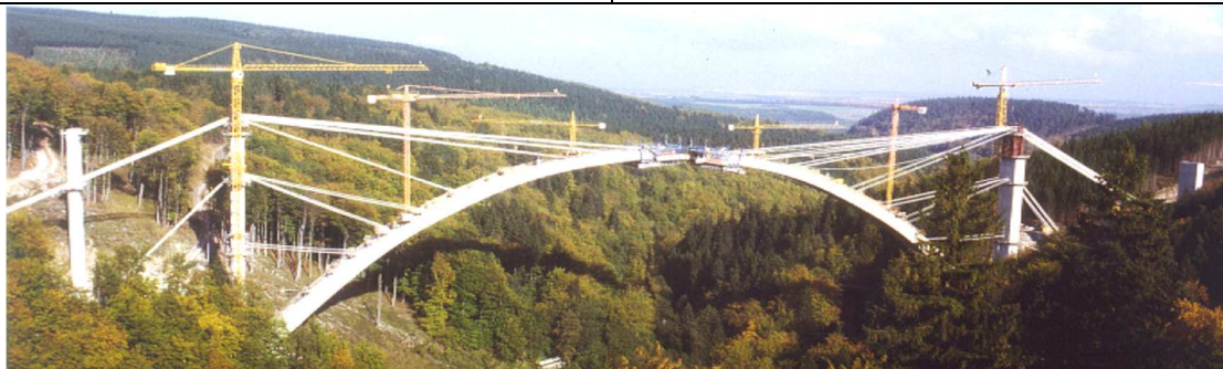
圖 3.4-9 施工當時狀況
