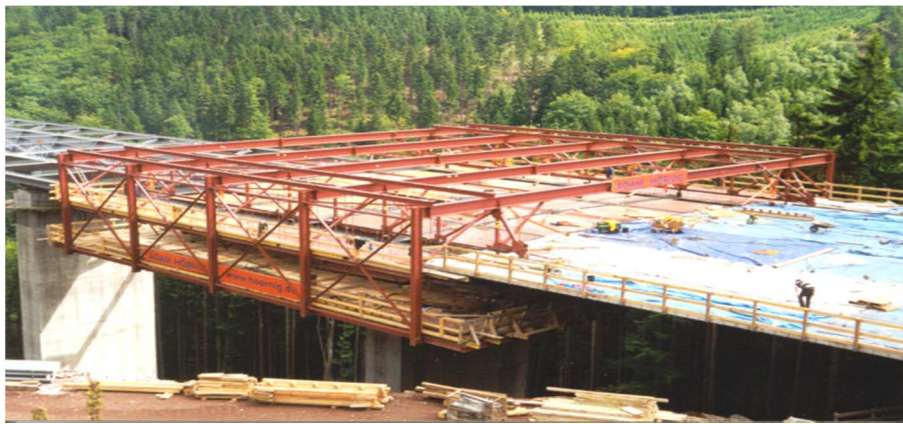
圖 3.4-11 橋面板推進施工(二)
