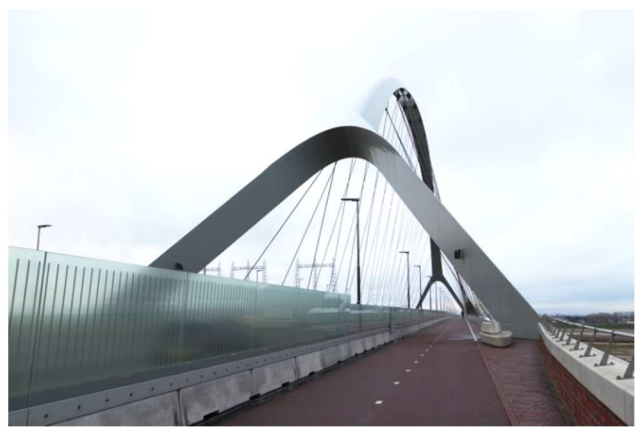
圖 3.4-35 Nijmegen De Oversteek 橋
