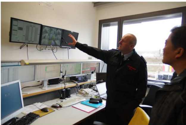
圖 3.2-7 消防隊內之監控系統
