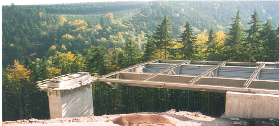
圖 3.4-10 橋面板推進施工(一)
