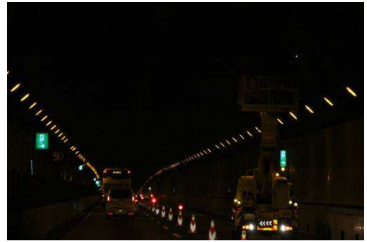
圖 3.4.2-2 笹子隧道施工交維
