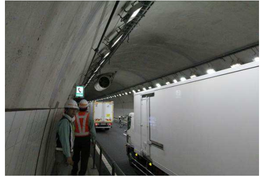
圖 3.4.1-4 愛川隧道內部訪察
