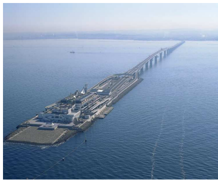
圖 6.1-3 東京灣跨海大橋
