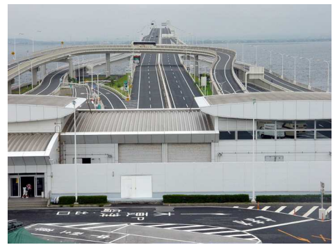
圖 6.1-4 東京灣跨海公路人工島
