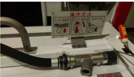
圖 3.3-6 模型展示-隧道消防栓
