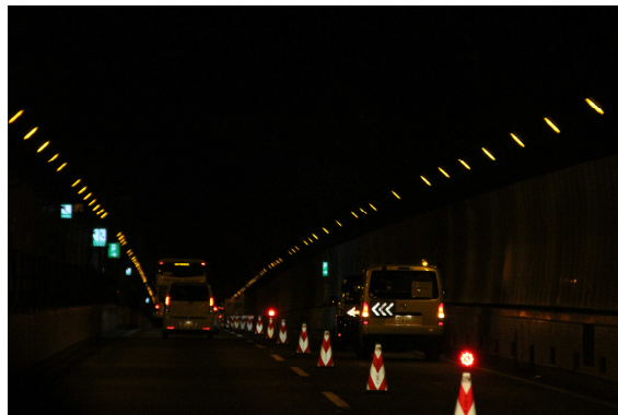
圖 7-1 隧道內交維佈設情形
