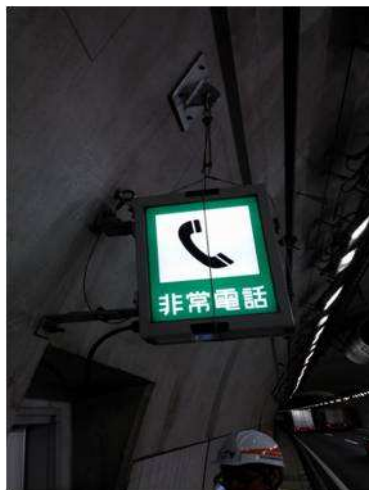
圖 7-3 設備加固鋼繩二次保護
