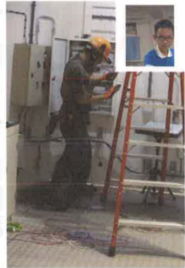
電氣裝配(室內配線)職類選手高○宗參加競賽情形
