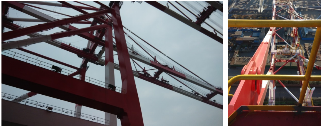
圖 2.2-12 基隆港與高雄港主要鋼結構組立照
