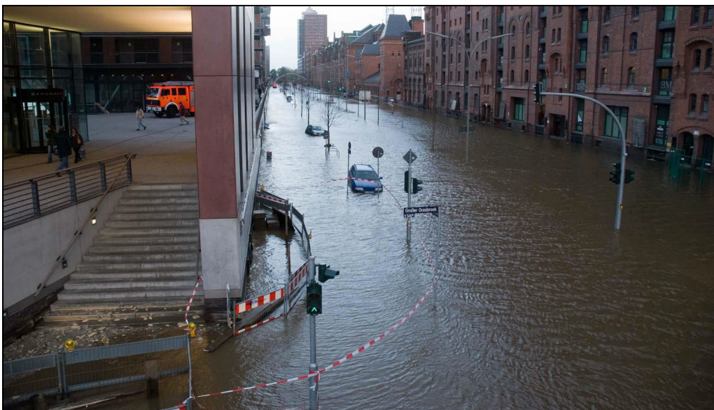
圖 12 德國漢堡地區防洪設施-建築物基礎堆高
