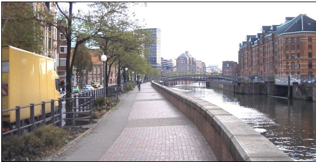
圖 11 德國漢堡地區防洪設施-防洪牆
