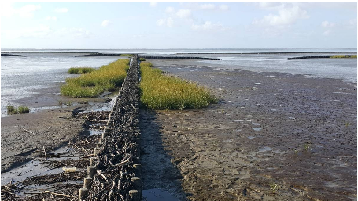
圖 21 下薩克森州諾爾登(Norden)海岸地區採近自然工法進行海岸保護措施
