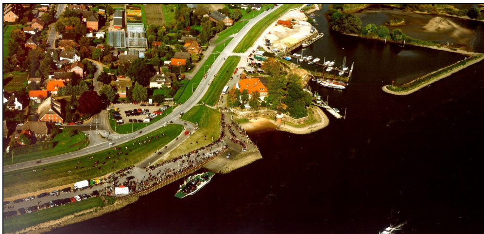
圖 9 德國漢堡地區防洪設施-堤防
