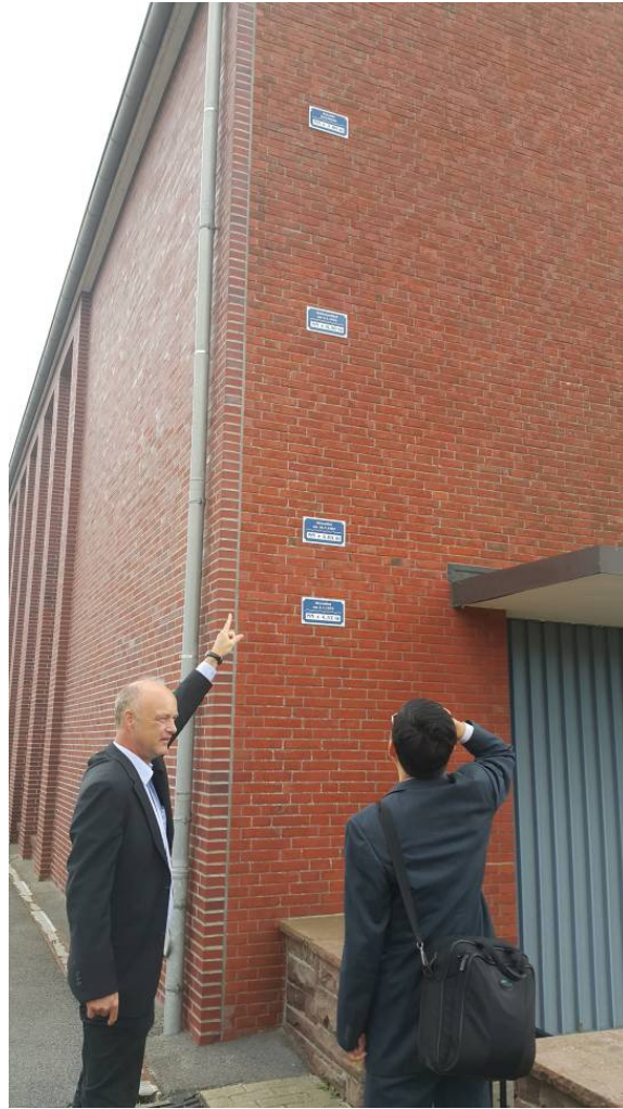
圖 20 下薩克森州諾爾登(Norden)海岸地區歷年較大淹水事件淹水高度標示
