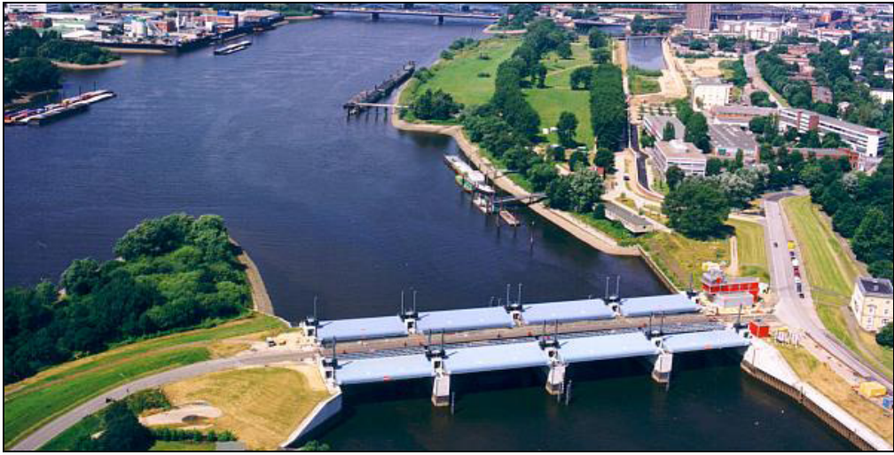
圖 10 德國漢堡地區防洪設施-防洪屏障
