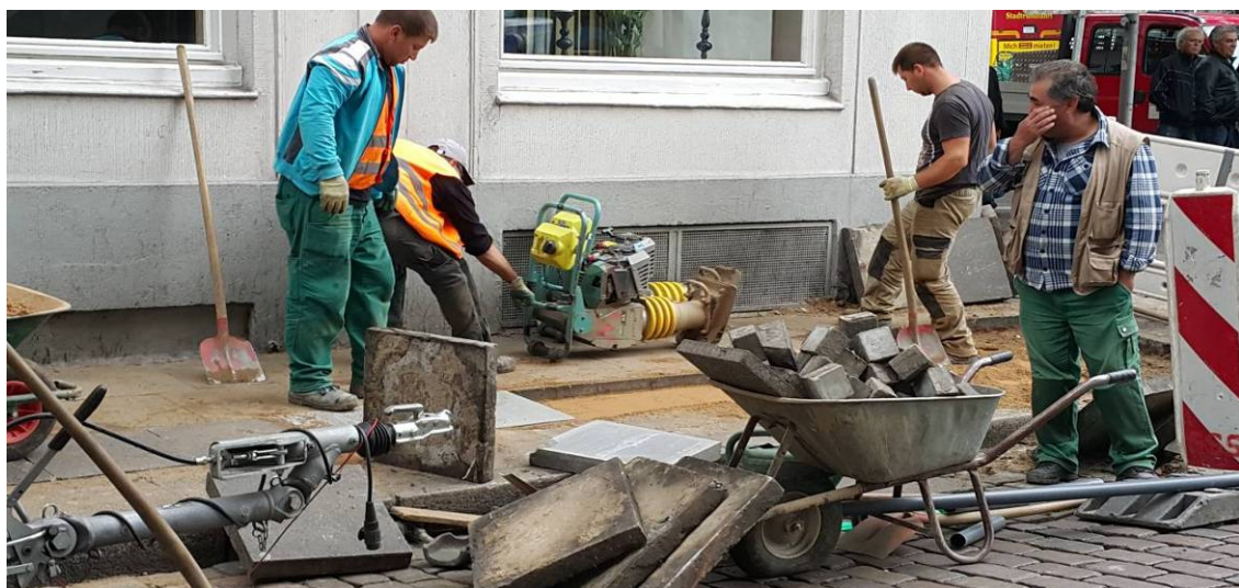
圖 14 人行道鋪面採用透水性設計及施工
