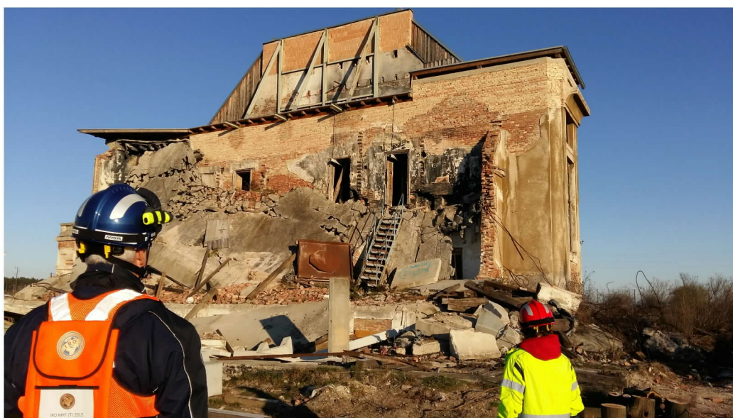
圖 10：半面倒塌建築物搜尋
