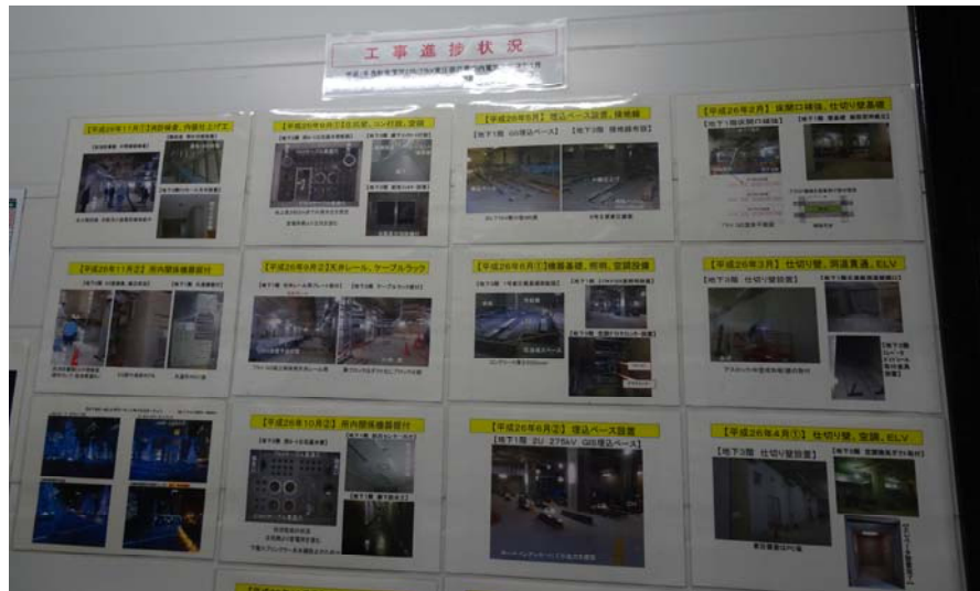
圖18 牛島町變電所施工過程紀錄
