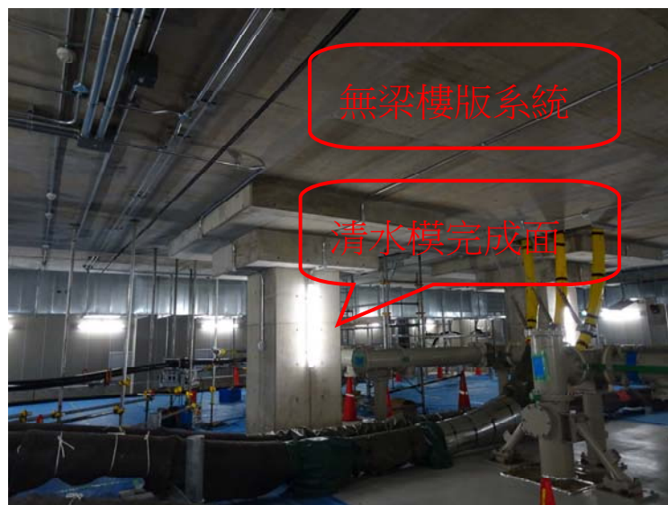
圖22 無梁樓版系統——採清水模工法
