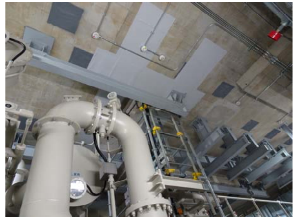
圖40 牛島町變電所內部明管施設
