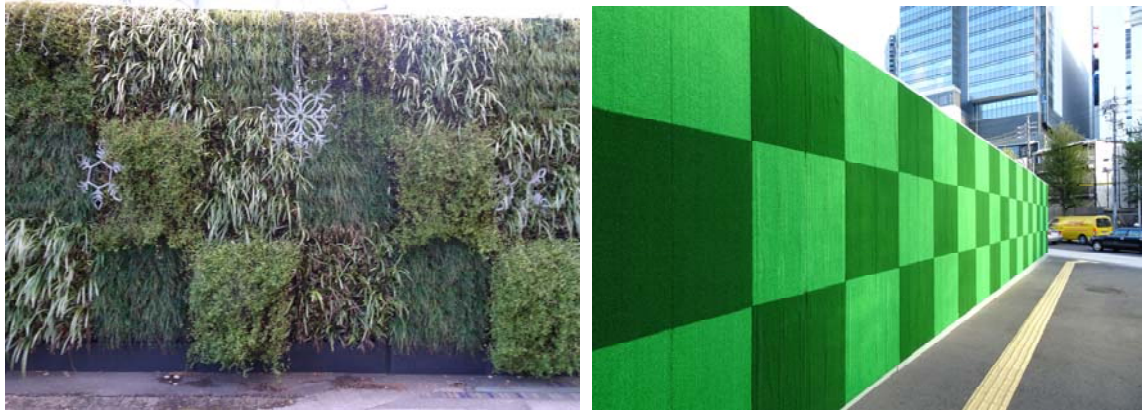
圖36 牛島町變電所臨時圍籬綠化工程
