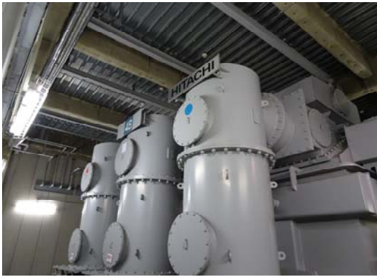
圖25 牛島町地上變電所之地下一樓——154/33kV主變壓器室
