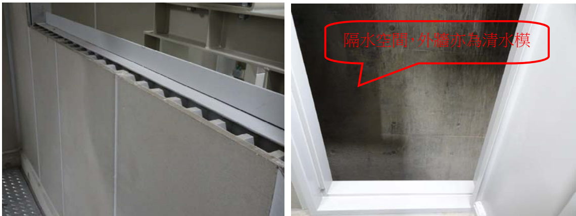
圖35 牛島町變電所地下二重壁實例
