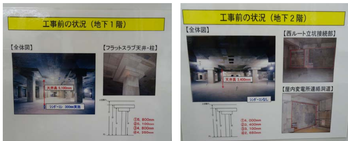
圖16 牛島町地下變電所各樓層配置(土建完工狀況)
