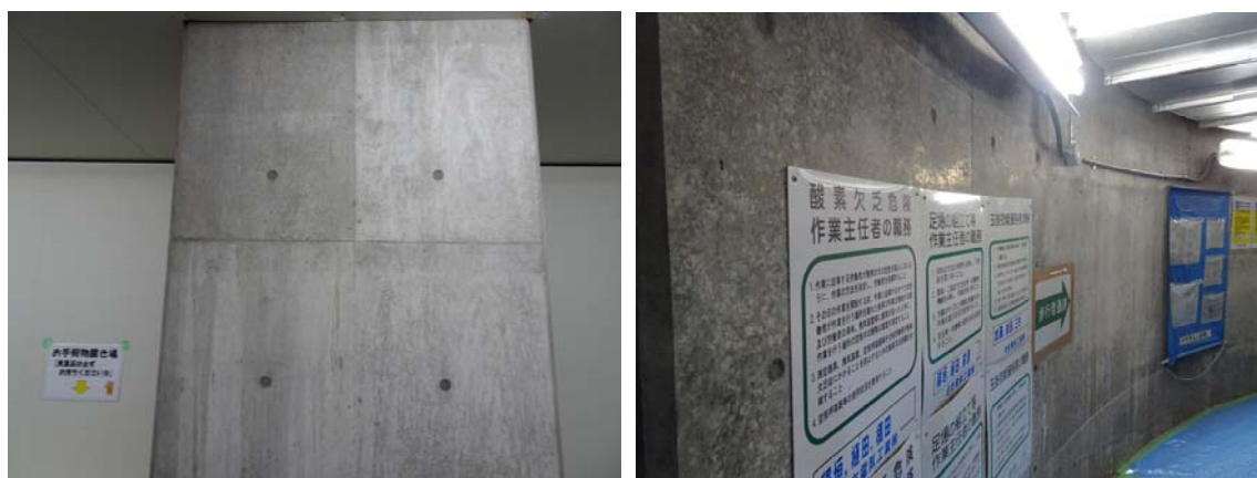
圖31 牛島町變電所清水模完成面(平面及曲面)良好
