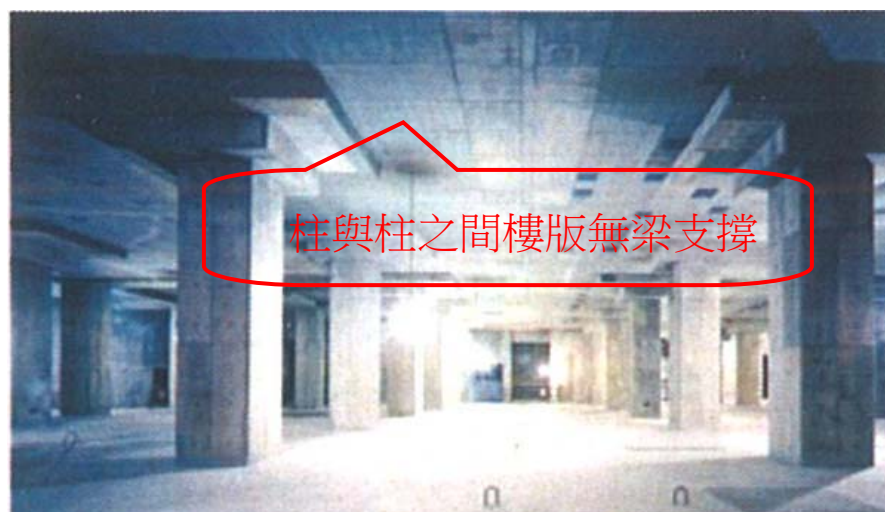
圖17 樓版系統採用無梁版型式
