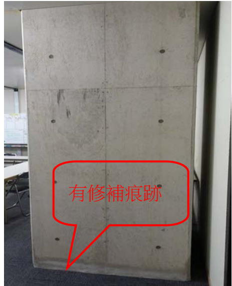
圖39 牛島町變電所清水混凝土實例
