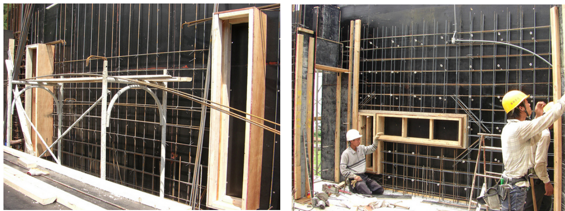
圖8 清水模工法施工過程(來源:網路照片)
