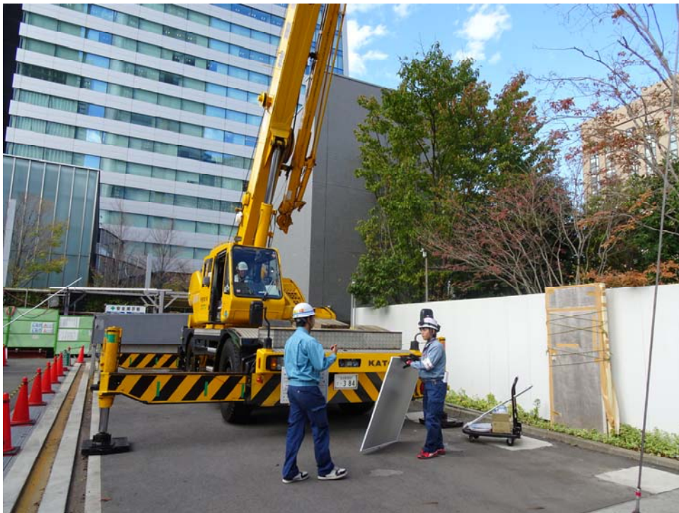
圖12 工作人員進行移動式起重機吊掛作業
