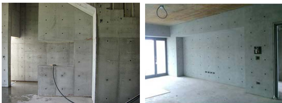
圖9 清水混凝土拆模後情形(來源:網路照片)
