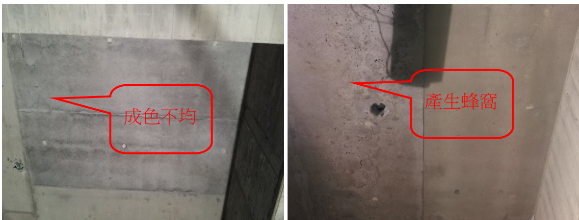
圖38 本公司某開關場天花板清水混凝土實例
