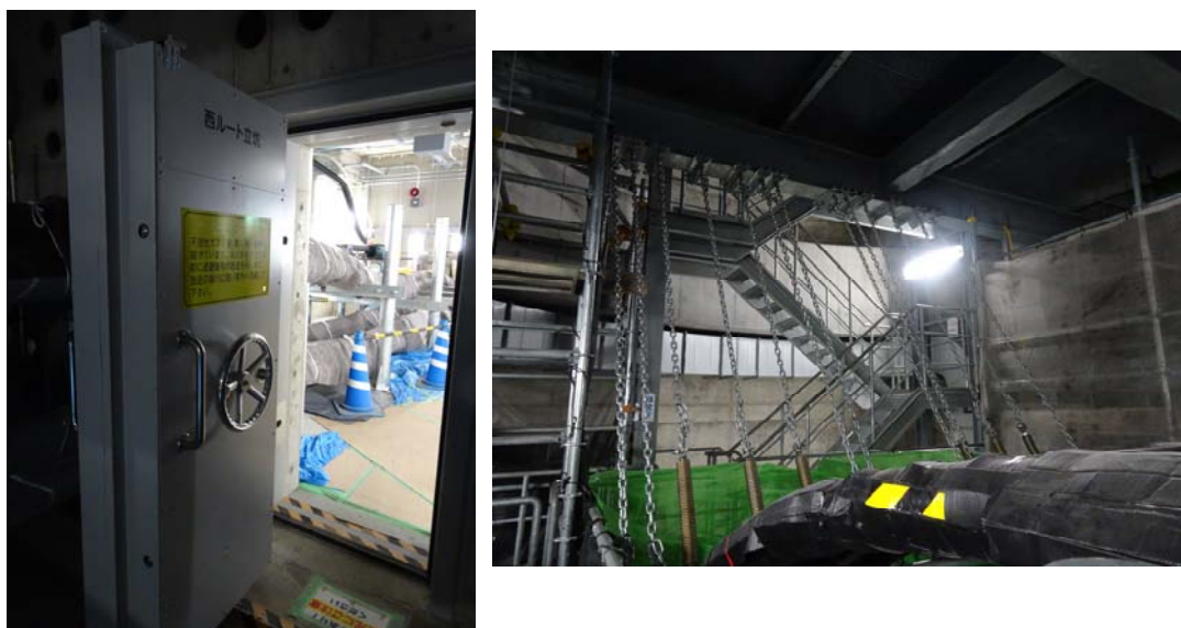
圖23 牛島町變電所之間的立坑通道
