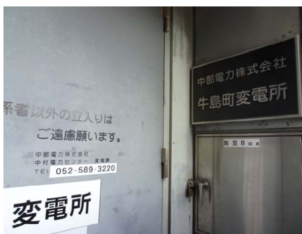
圖29 變電所基地側門
