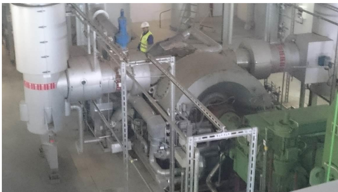
圖 17 汽電共生發電機組
