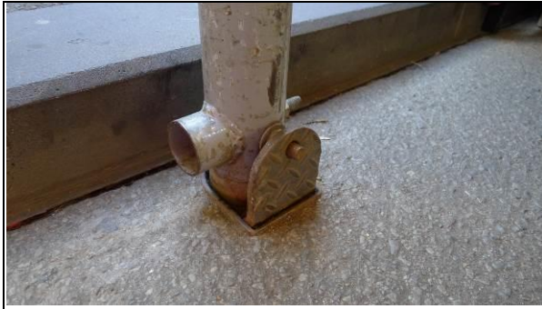
圖 45：搭設棚架之掀蓋式基礎
