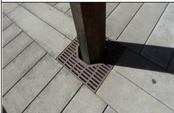
圖 37：高架鋪面與木柱接合處理
