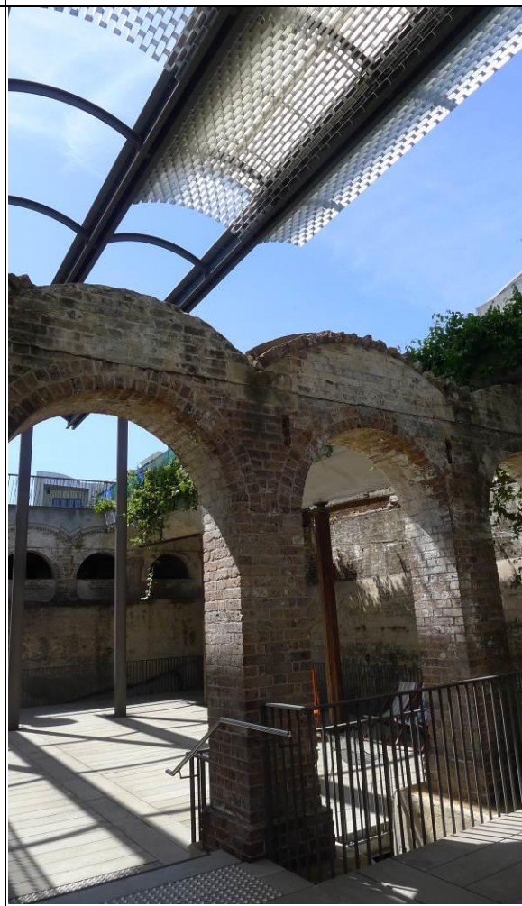
圖 32：延續舊屋梟新增的遮陽設施
