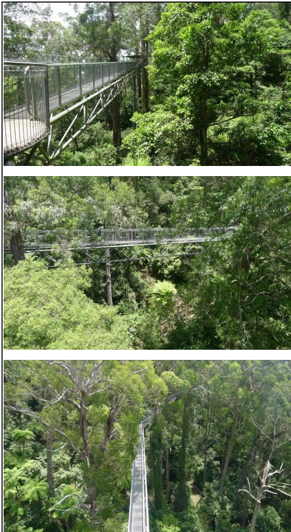
圖 118：高架棧橋結構
