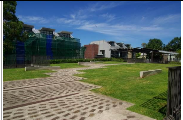
圖 34：東側地面層鋪面
