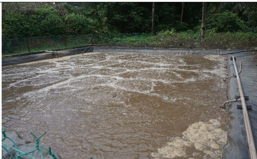
圖二：養豬場廢水曝氣池
