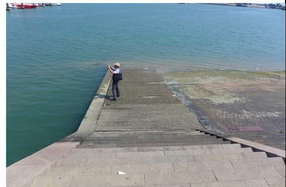
上下水坡道旁樓梯
