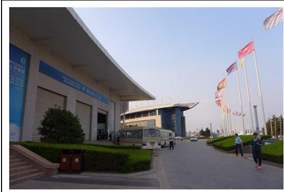
艇庫丈量室外觀
