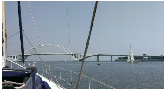
水面至橋底部高度約 18 公尺，不具有開啟功能
