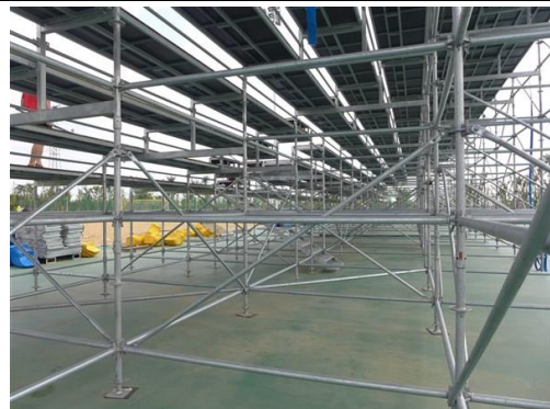
租賃組裝式看台下部結構
