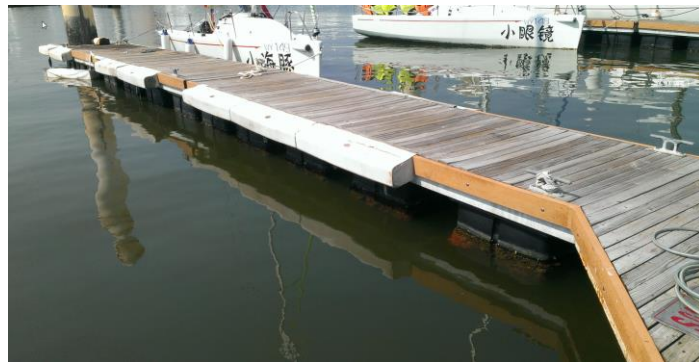
採用箱體型浮動平台，通道部分使用仿木，部分使用南洋檫木。
