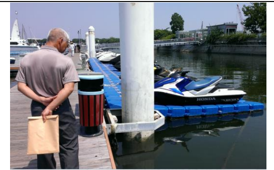
水上摩托車僅供停泊，不可載客營業。浮動平台支柱之軌道間隙似過大。
