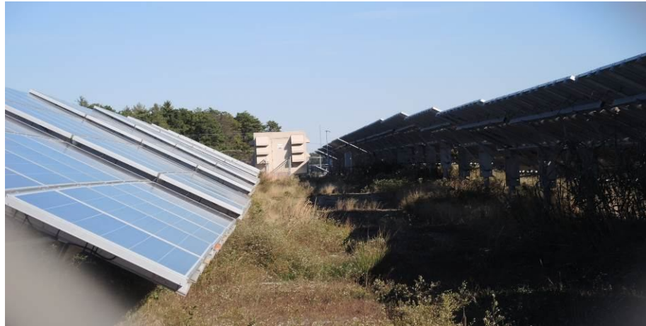
圖 27、太陽能發電廠之逆變器(遠方建築物內)
