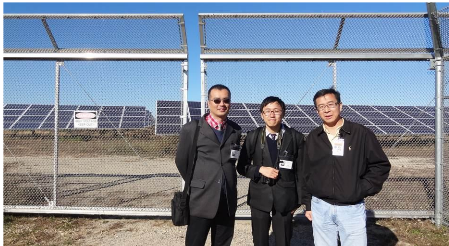
圖 31、(上) 商用型 32MW 太陽能發電廠空照；(下) 圍欄前合照
